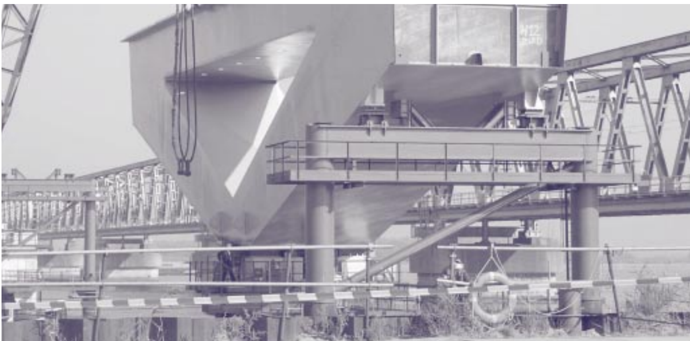
Brug Hollandsch Diep: plaatsing van hamerstuk.
