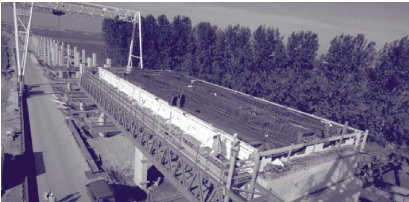
Doorgaand spoorviaduct Bleiswijk: storten van dekken in voorbereiding.
