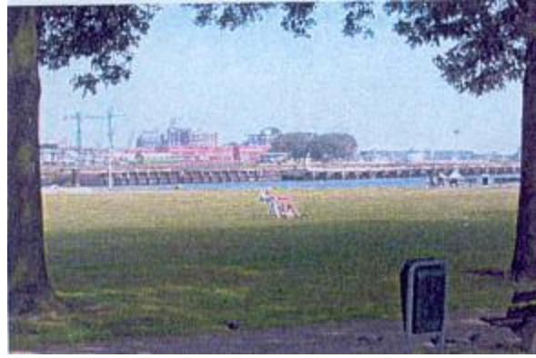
2. Charloisse Hoofd (waterzijde) vòòr de herinrichting
