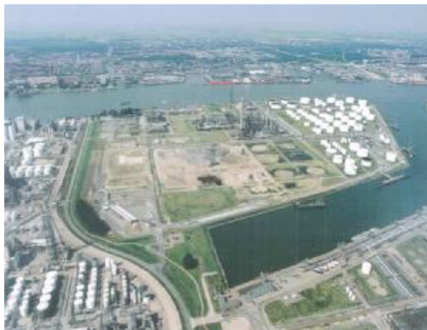
2. Terrein Nerefco: verwijderde opslagterminals
