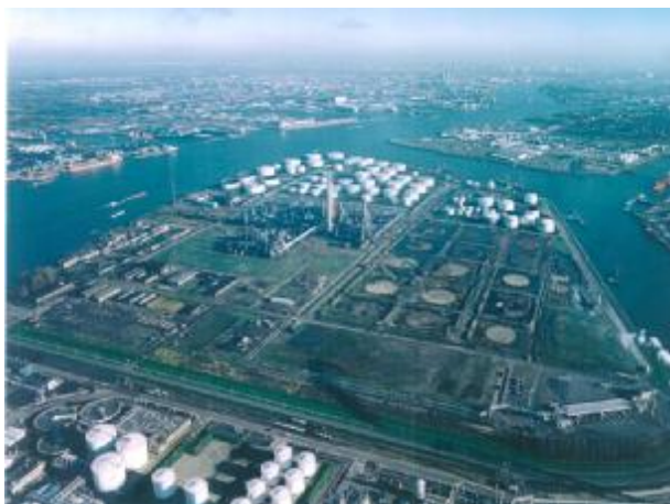
1. Terrein Nerefco: verwijderde opslagterminals
