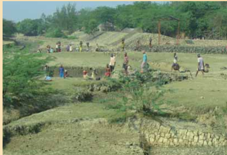
Bouw van dijken in de Ganges delta (India, Bangla Desh). Hier valt nog wel wat winst door aanpassing te behalen.
