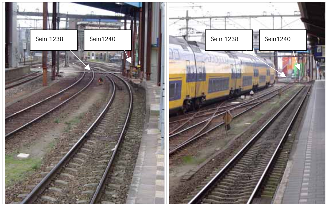
Foto's 4 en 5: De plaatsing van de seinen 1238 en 1240 te Arnhem.
