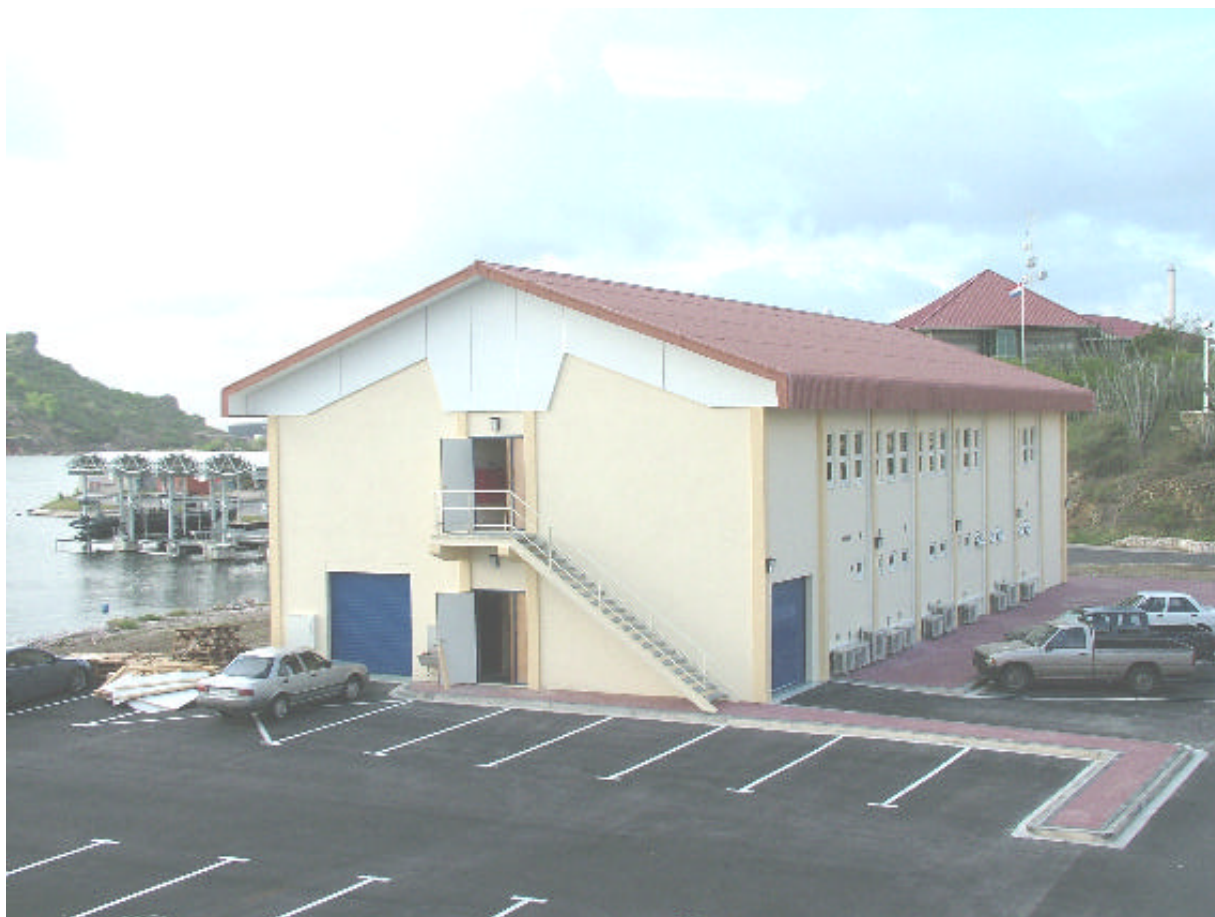
Het nieuwe steunpuntgebouw op Curaçao
