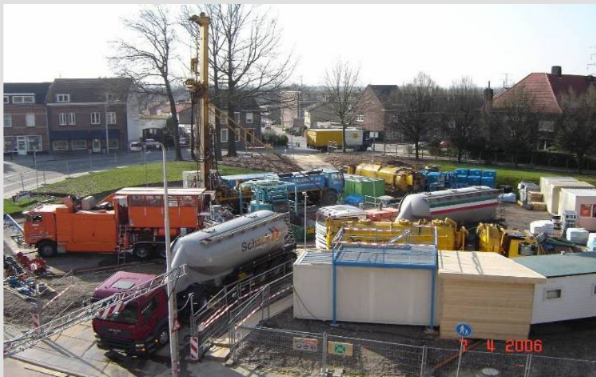
Cementatie 13 3/8" casing op HH-02 (Foto: SodM)
