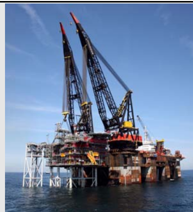
Installatie P11-B De Ruyter PetroCanada (Foto: PetroCanada)
