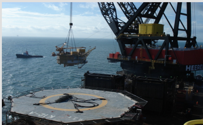
Het maindeck K12-A in de hijskabels van de Thialf. Op de voorgrond het eerder gehesen helideck (Foto: SodM)
