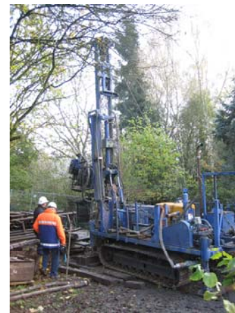
Beveiligingwerkzaamheden Trempelwerk (Foto: SodM)
