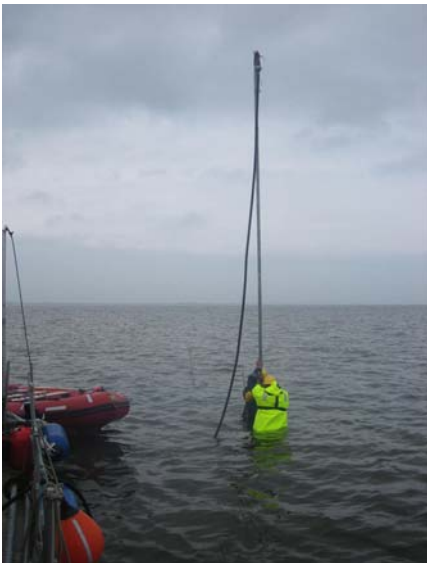
Meetanker van 6 m lengte, die door middel van een krachtige waterstraal in de bodem van de Waddenzee wordt geïnstalleerd. (voorjaar 2006)
