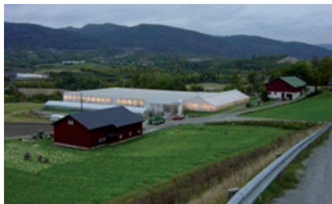
Door Priva gerealiseerd project in Frankrijk.
