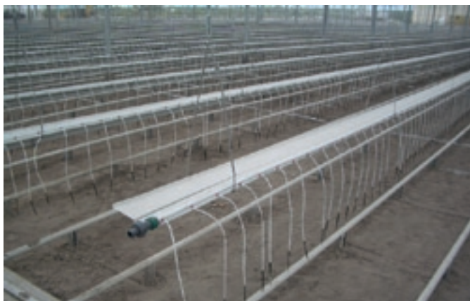
Deze en volgende pagina: het in aanbouw zijnde Levarht-project op het agribusinesspark in Mexico.
