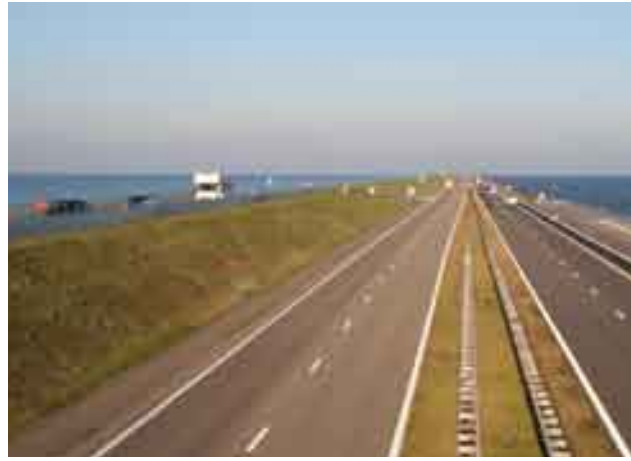
Zicht op Afsluitdijk
