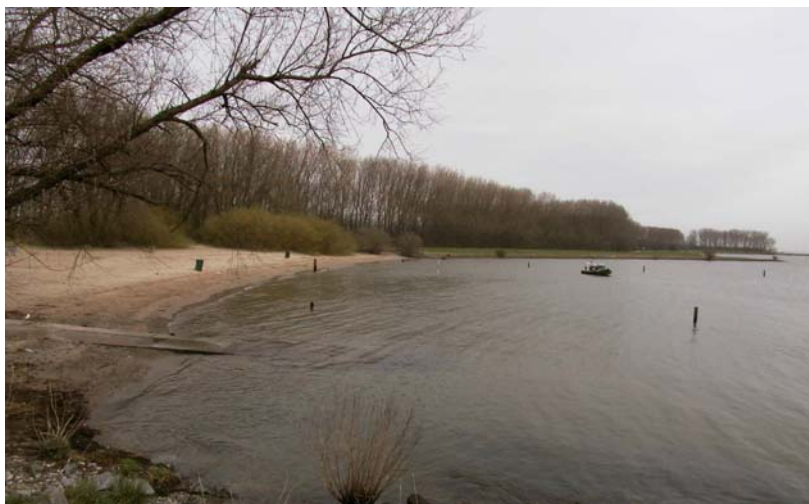
..... Foto 7: RWS ZH Haringvlietbrug landhoofd Noord-Oost
