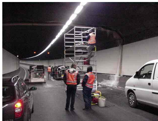
Fig 10.5.4 Opbouw steiger oostbuis
