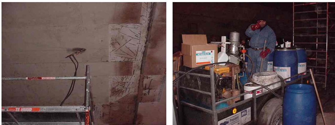
Fig 10.10.1 Het gat is geboord door de hittewerende beplating Promatec en het injectiepistool van de twee componentenpomp is op de packer in het boorgat aangesloten. In het dak naast de dilatatievoeg zijn een aantal lekplekken nog zichtbaar. De hoek naar de voeg is onder 30 graden boven het rubberprofiel geboord, rekening houdend met de richting van de veranding in het dak. Na het gereed maken van het mengen van de injectievloeistof met de zoutcomponent kan worden geïnjecteerd. Het lekwater voert de injectievloeistof mee naar alle lekplekken.
