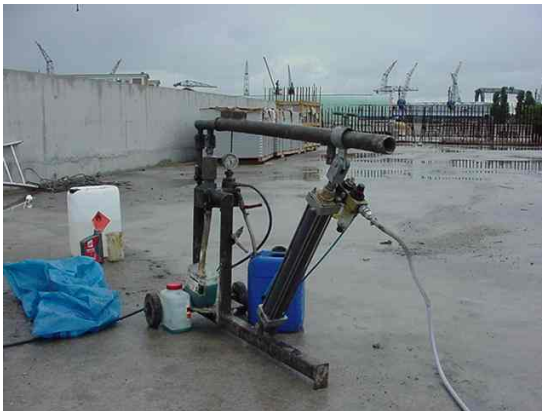
Fig 10.11.17 Injecteren dak met Polymert 150 mpa.
