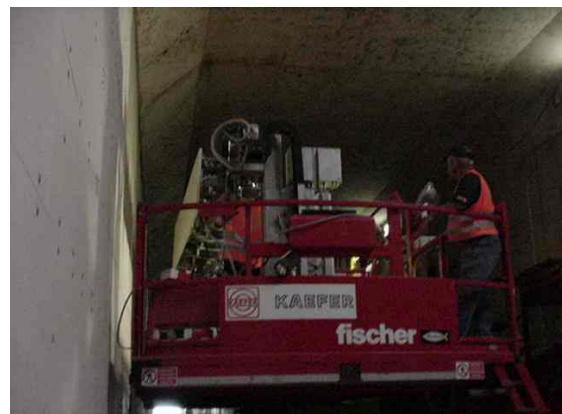
Fig 10.13.2 Automaat aanbrengen hittewerende platen
