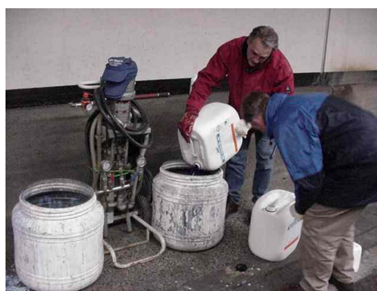
Fig 10.5.6 Menging injectiecomponenten
