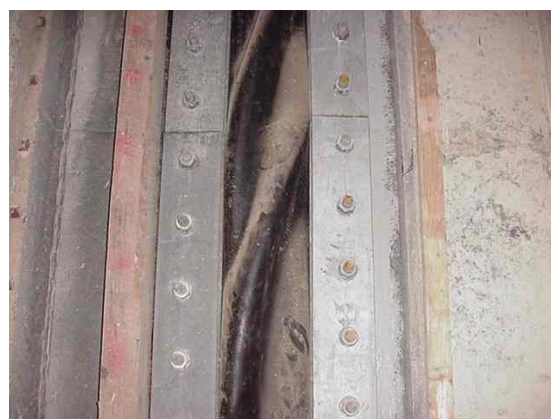
Fig 10.11.13 na zetting tunnelelement / landhoofd Zd 19-3-2000
