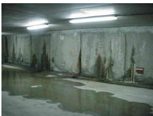
Fig 10.12.1 Alle paneelvoegen en de diepwand beton lekten. Fig 10.12.2 Het boorschema paneelvoegen
