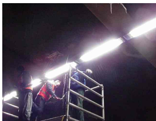
Fig 10.5.8 De injectievloeistof druipt overal uit de voeg op het wegdek
