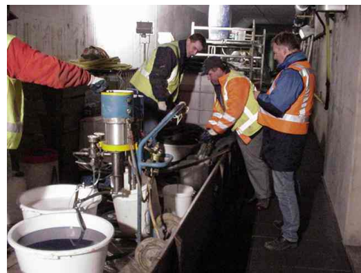
Fig 10.11.8 Voorbereiden injectievloeistof MC
