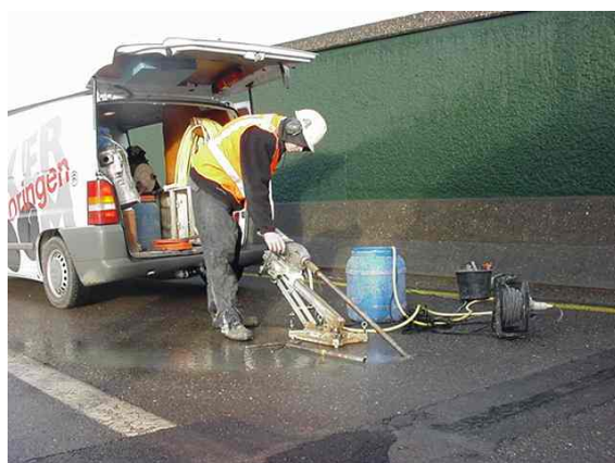
Fig 10.7.1 Het aanboren van de dilatatievoeg in de vloer onder het rubberprofiel, diameter 32 mm, diep ca. 80 cm.
