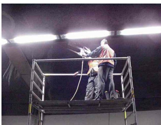
Fig 10.5.5 Aanboren dilatatievoeg boven rubberprofiel
