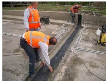
Fig 10.14.6-7-8 Betonoppervlak schoon blazen, plaatsen rubber slab W5B-10, montage klemlijsten en dilatatievoeg tempex.
