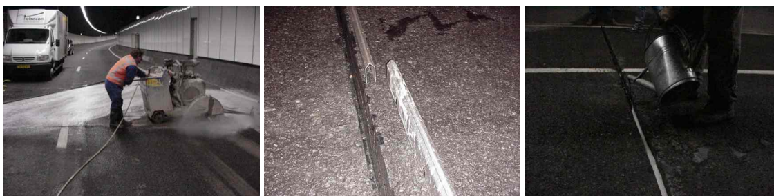
Fig. 10.5.9-10-11 Inzagen schijnvoeg met dubbele diamantzaag, plaatsen rvs afdekprofiel en bezanden en aangieten met een rubber bitumen "Carifalt"
