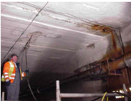
Fig 10.11.9 Na contact retourwater injecteren met MC GL95TX
