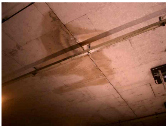
Fig 10.10.2 Lek in dak bij dilatatievoeg
