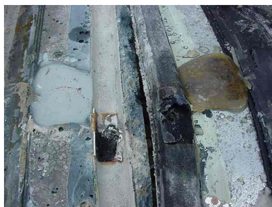
Fig 12.10 Opengemaakte balk met luchtbellens en injectiehars
