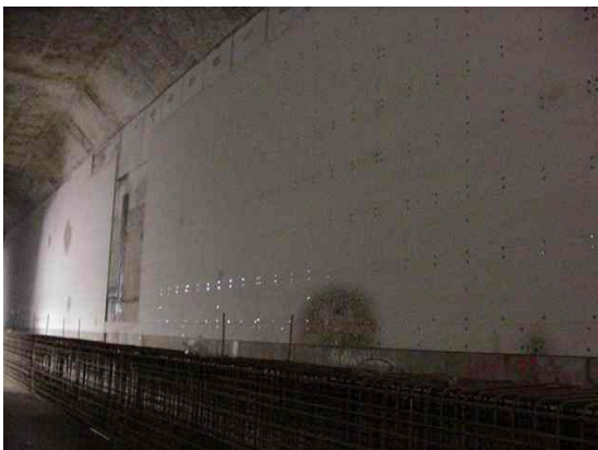
Fig 10.13.3 Waterdoorslag door hittewerende platen
