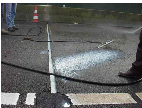
Fig 10.7.4 Plaatsen injectiepistool op packer.
