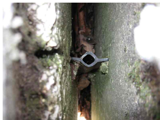
Fig 10.14.3 Het rubber W3A profiel in de dilatatievoeg
