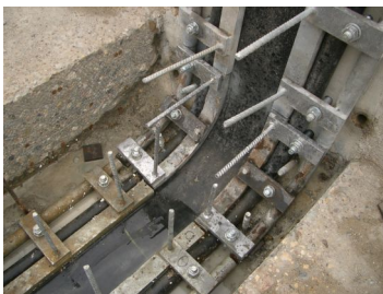
Fig 10.14.9-10-11 Bochtstukken met extra ankers, aanstorten sparing met staalvezelbeton
