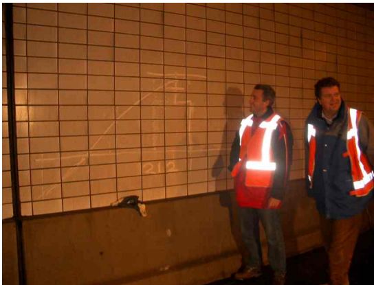
Fig 10.10.4 Controle maatvoering op de tegelwand
