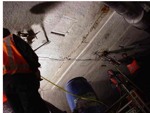
Fig 10.11.5 Alle materiaal & materieel op de spoorwagen. Fig 10.11.6 Gelijktijdig aanboren twee gaten
