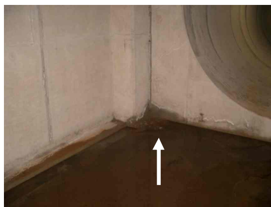
Fig 10.9.2 Wapeningstekening met rubbermetaal voegstrook van kopschot tunnel. Een zakking van het kopschot (nu 5 cm) betekent een verticale vervorming in de wanden. De vierkante koker is onderheid. Het voegprofiel (witte pijl) is van de toegangskoker en het andere voegprofiel van een aansluitende vleugelwand / talud spoorlijn.
