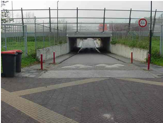
Fig 10.15.1 Tunneltje Sluisweg Hardinxveld A15
