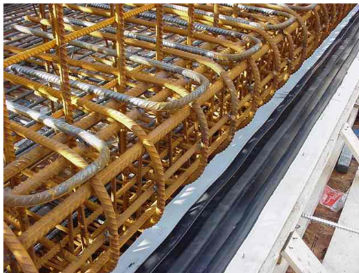
Fig 3.5-3.6 Nieuw ontwerp prefab wapening rondom de rubbermetaal voegstrook (Calandtunnel)
