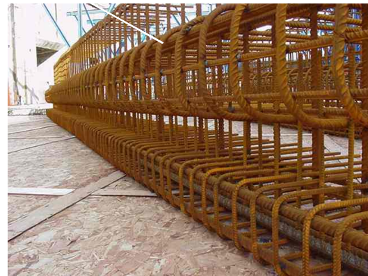
Fig 3.5-3.6 Nieuw ontwerp prefab wapening rondom de rubbermetaal voegstrook (Calandtunnel)
