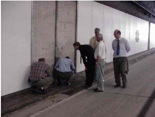
Fig 10.3.1 Inspectie team onderzoekt schade dilatatievoeg Fig 10.3.2 Scheur in voeg 2cd buitenwand zuidbuis
