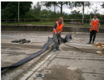
Fig 10.14.6-7-8 Betonoppervlak schoon blazen, plaatsen rubber slab W5B-10, montage klemlijsten en dilatatievoeg tempex.
