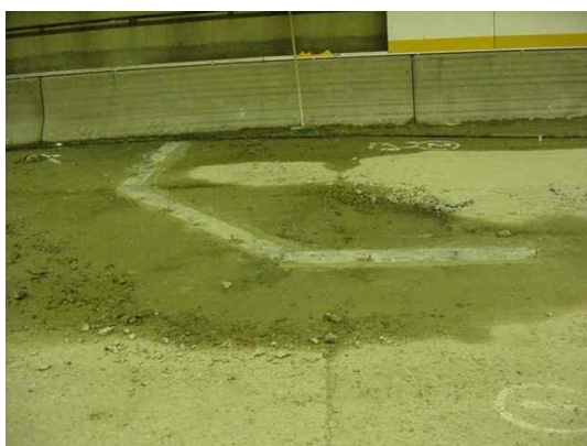
Fig 10.2.4 Waterafvoergoot in de ballast betonvloer Fig 10.2.5 Staalplaat op goot dilatatievoeg
