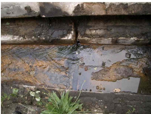
Fig 10.16.7. Het lekwater stroomt direct in de goot
