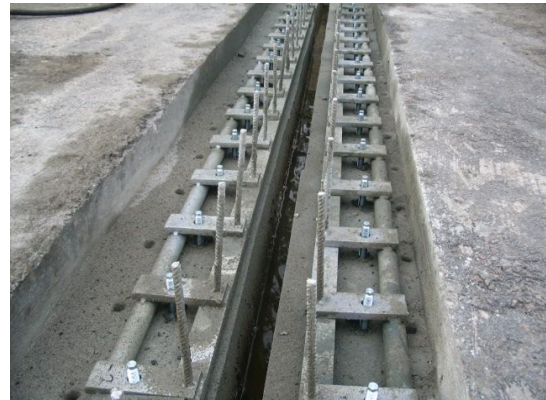
Fig 10.14.5 Verzinkte klemlijsten voor gemonteerd om gaten voor de ankers op maat te boren.
