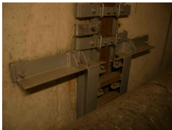
Fig 10.1.2 De stalen klemconstructie met hardhouten verwigging op het platte rubberprofiel.
