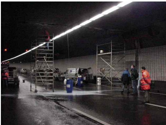
Fig 11.9 Injectie dakvoeg Noordtunnel
