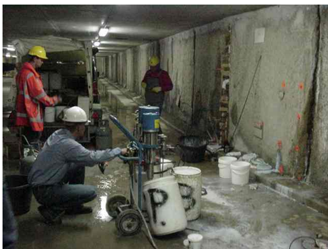
Fig 10.12.3 -4 Injecteren met MC GL 95 TX. Om de stroming van het water en het verlies van injectiemateriaal te beperken werden in de voeg lorren en houten wiggen geslagen.
