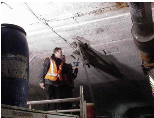
Fig 10.11.7 Na verwijderen boor stroomt veel water uit de voeg, waar ca. 15 m waterdruk op staat.
