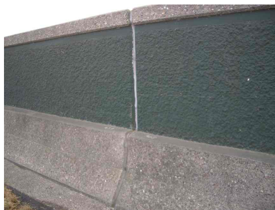
Fig 12.9.2 Dilatatievoeg buitenwand
