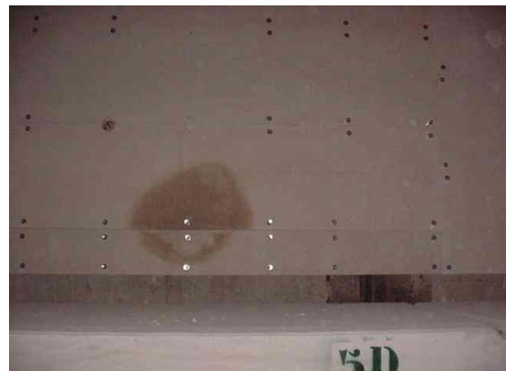
Fig 10.13.4 De hw platen zitten met bouten vast
