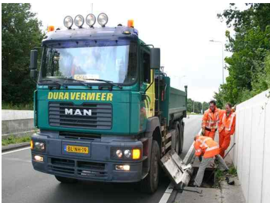
Fig 10.16.5 Met hiab kraanauto tegels opgetild.
