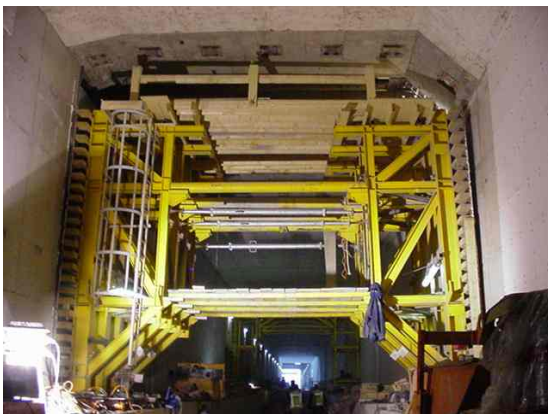
Fig 10.13.1 Doorkijk tunnel met bekisting zinkvoeg
