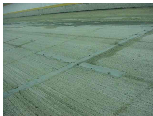
Fig 10.2.4 Waterafvoergoot in de ballast betonvloer Fig 10.2.5 Staalplaat op goot dilatatievoeg
