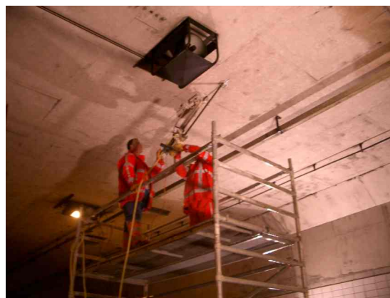
Fig 10.10.3 Aanboren dilatatievoeg in dak
