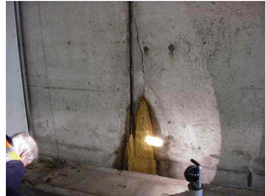
Fig 10.3.1 Inspectie team onderzoekt schade dilatatievoeg Fig 10.3.2 Scheur in voeg 2cd buitenwand zuidbuis
