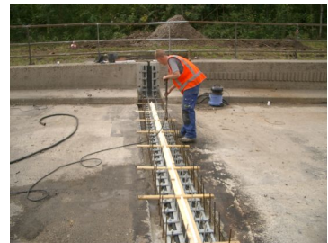
Fig 10.14.6-7-8 Betonoppervlak schoon blazen, plaatsen rubber slab W5B-10, montage klemlijsten en dilatatievoeg tempex.
