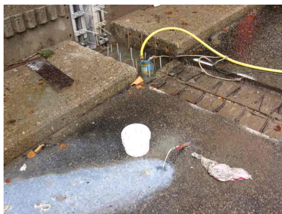
Fig 10.14.18 Twee gaten geboord en injectie gestart. Fig 10.14.19 Controle dichtheid op nog openstaand bochtstuk.
