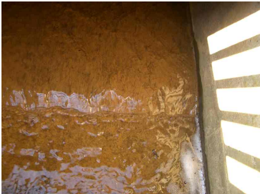
Fig 10.16.3 Lekwater in goot onder trottoir
