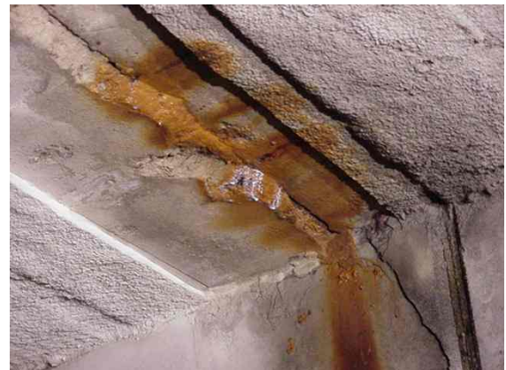
Fig 11.10 Injectie voeg metrobuï Beneluxtunnel
