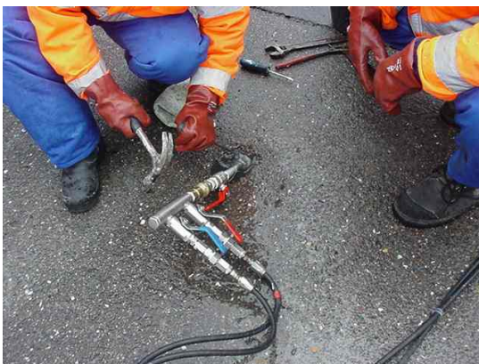
Fig 10.7.4 Plaatsen injectiepistool op packer.
