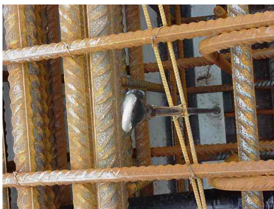
Fig 4.3 De metaalstrook is via een stalen injectie pen opgehangen en vastgemaakt aan de bovenwapening
