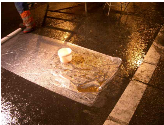
Fig 10.10.6 Injecteren water met kleurstof. Eerst een licht rose verkleuring. Fig 10.10.7 Daarna een donkerder rode kleur. Er is verbinding met de lekweg door de dilatatievoeg. Bepalen uitstroomtijd gekleurd water voor de bepaling van de zoutdosering injectievloeistof MC.
