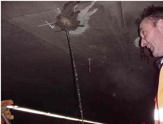
Fig 10.6.4 De dilatatievoeg is aangeboord en stroomt het water uit het gat en uit de voeg boven het rubberprofiel. De beton boorkernen worden gecontroleerd.
