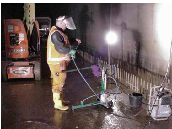
Fig 10.13.5 Handmatig injecteren met Polyment 10 en of 27 mpas
