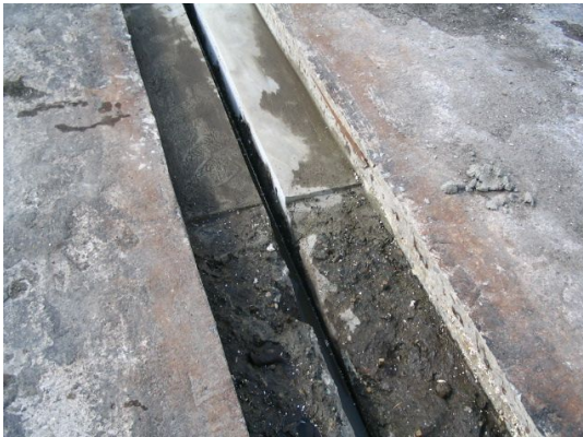
Fig 10.14.4 3 Ingezaagde sparing, beton gesloopt, met cement mortel uitvklaklaag aangebracht.
