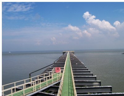
Koelwaterkanaal met aan het eind de inlaattoren
