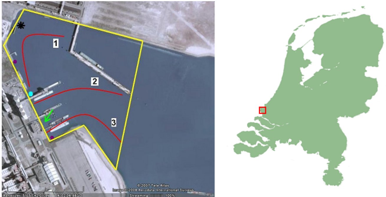
Figuur 2.1 Het onttrekkingsgebied voor de koelwaterinlaat van de E.ON-centrale (geel).
