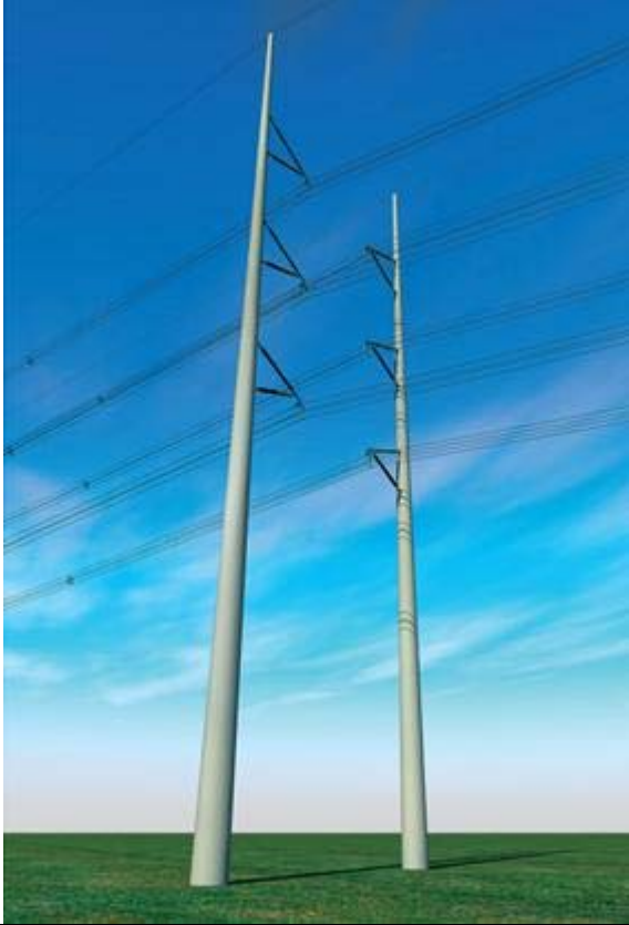
Figuur 3.1 M-compactmast (380 kV dubbelcircuit)
