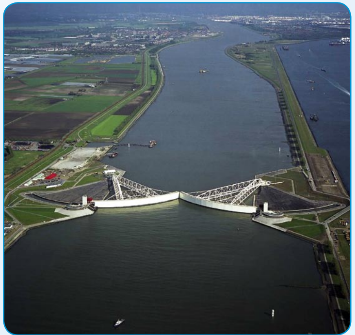
Gesloten Maeslantkering in de Nieuwe Waterweg.
