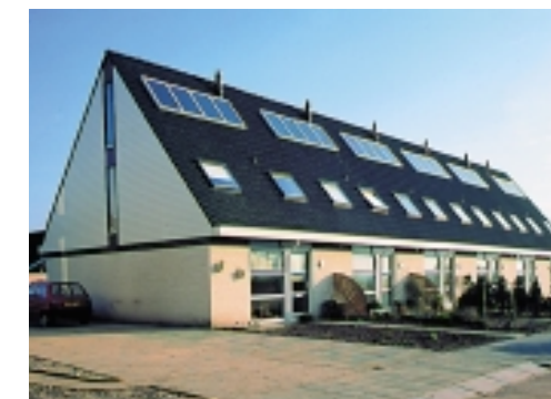
Vlakke plaat collectoren geïntegreerd in het dakvlak
