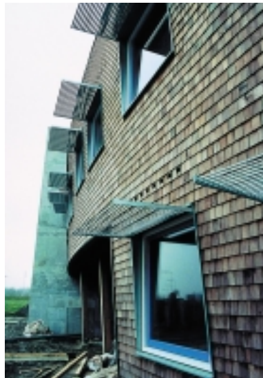
Om oververhitting in de zomer te voorkomen is vaste zonwering toegepast.
