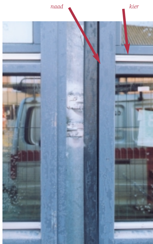
Bij een raampartij zijn zowel naden als kieren aanwezig.
