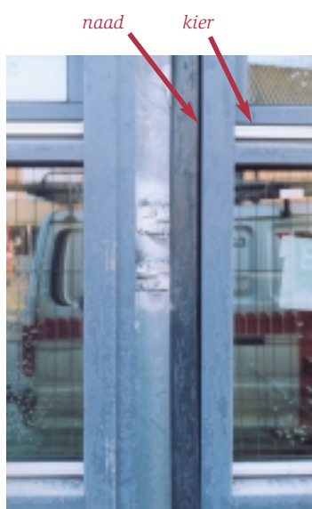
Bij een raampartij zijn zowel naden als kieren aanwezig.
