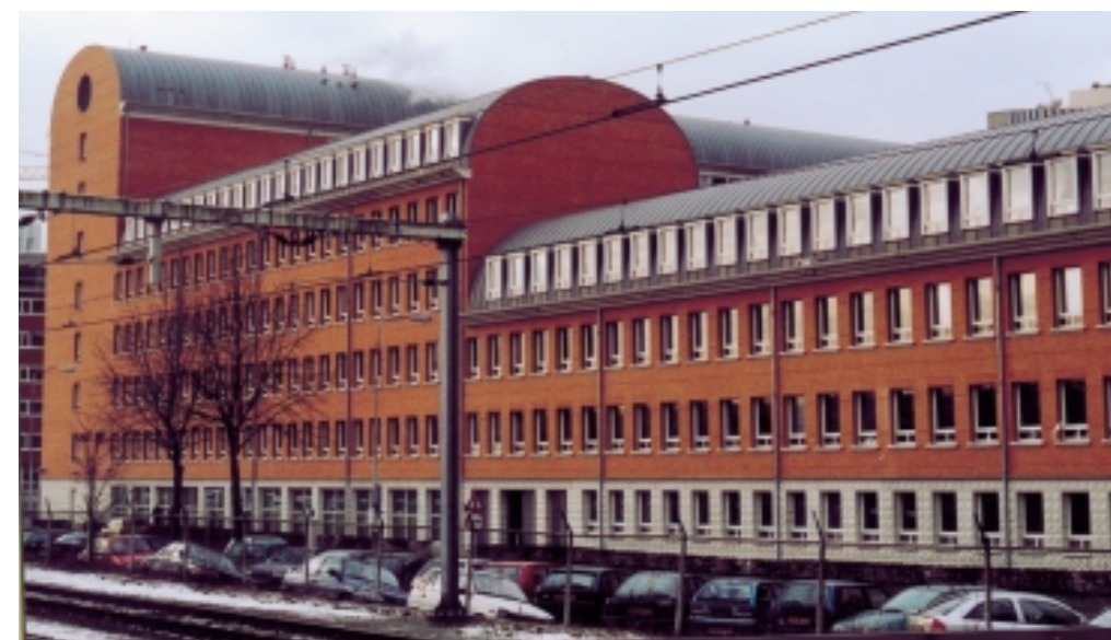
De bouwmassa van dit gebouw zorgt voor passieve koeling.
