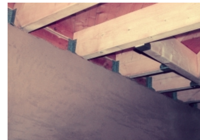
Een dikke laag leemstuc geeft de houten woning massa.
