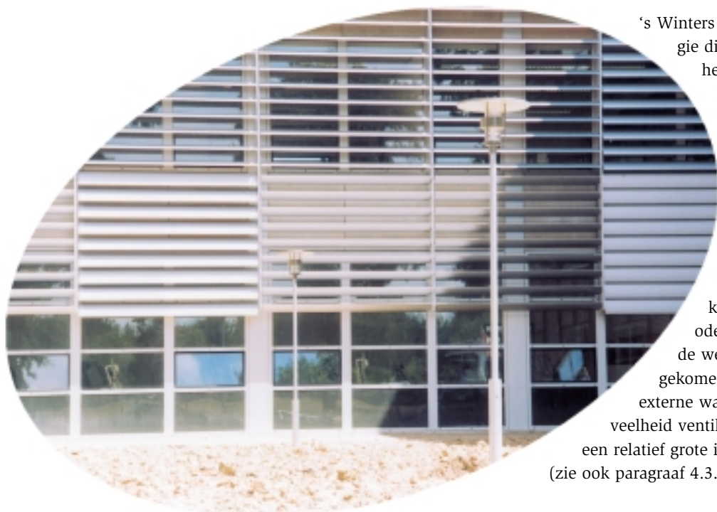
Om oververhitting in de zomer te voorkomen is vaste zonwering toegepast.
