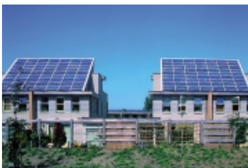
Pv panelen geïntegreerd in het dakvlak
