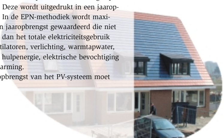
PV-cellen als film over een strook dakpannen
