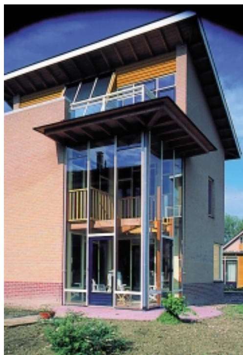
Een serre maakt het gebruik van passieve zonne-energie mogelijk.
