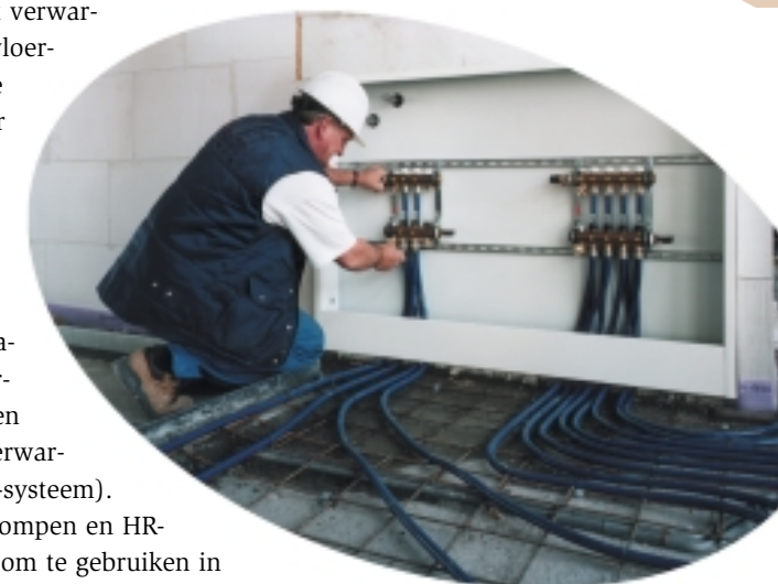
Bij dit lage temperatuur verwarmingssysteem wordt de warmte via leidingen in de vloer (vloerverwarming) gedistribueerd.
