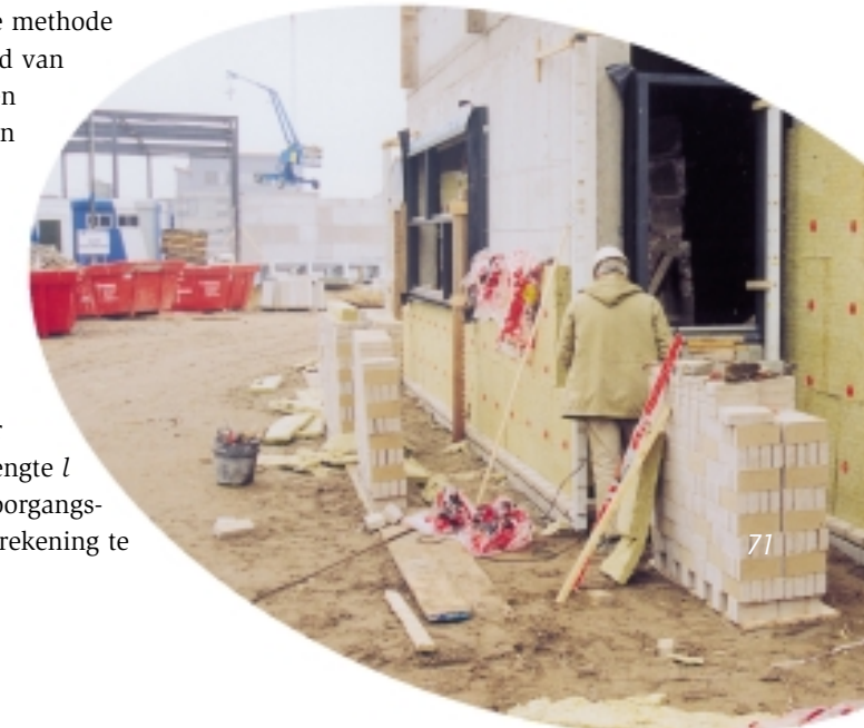
De spouwmuur wordt voorzien van minerale wol.
