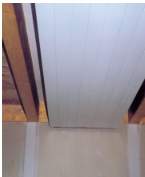
Een koelplafond kan als element tussen de (houten) draagstructuur worden geplaatst.
