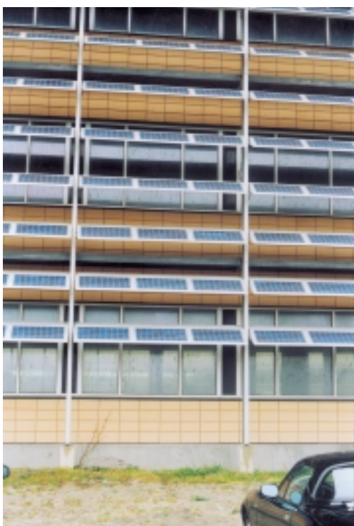
Een mooie manier om zonnecellen toe te passen is geïntegreerd in buitenzonwering.
