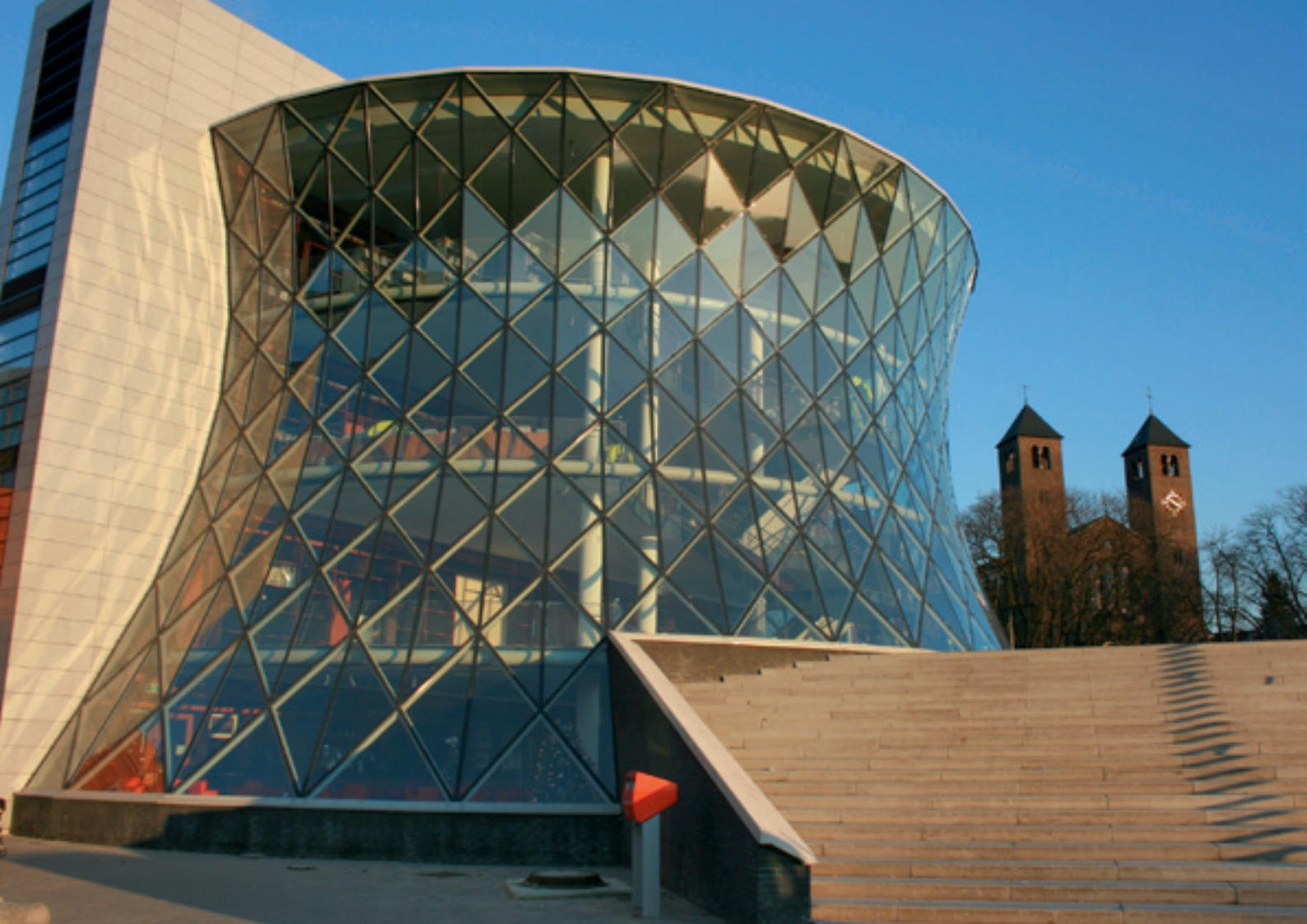
Kwaliteitsverhoging Parkstad Limburg/herstructurering Heerlerheide (nieuwbouwcomplex 'Gen Coel' in het stadsdeel Heerlerheide, gebaseerd op vorm oude mijnkoeltorens)
