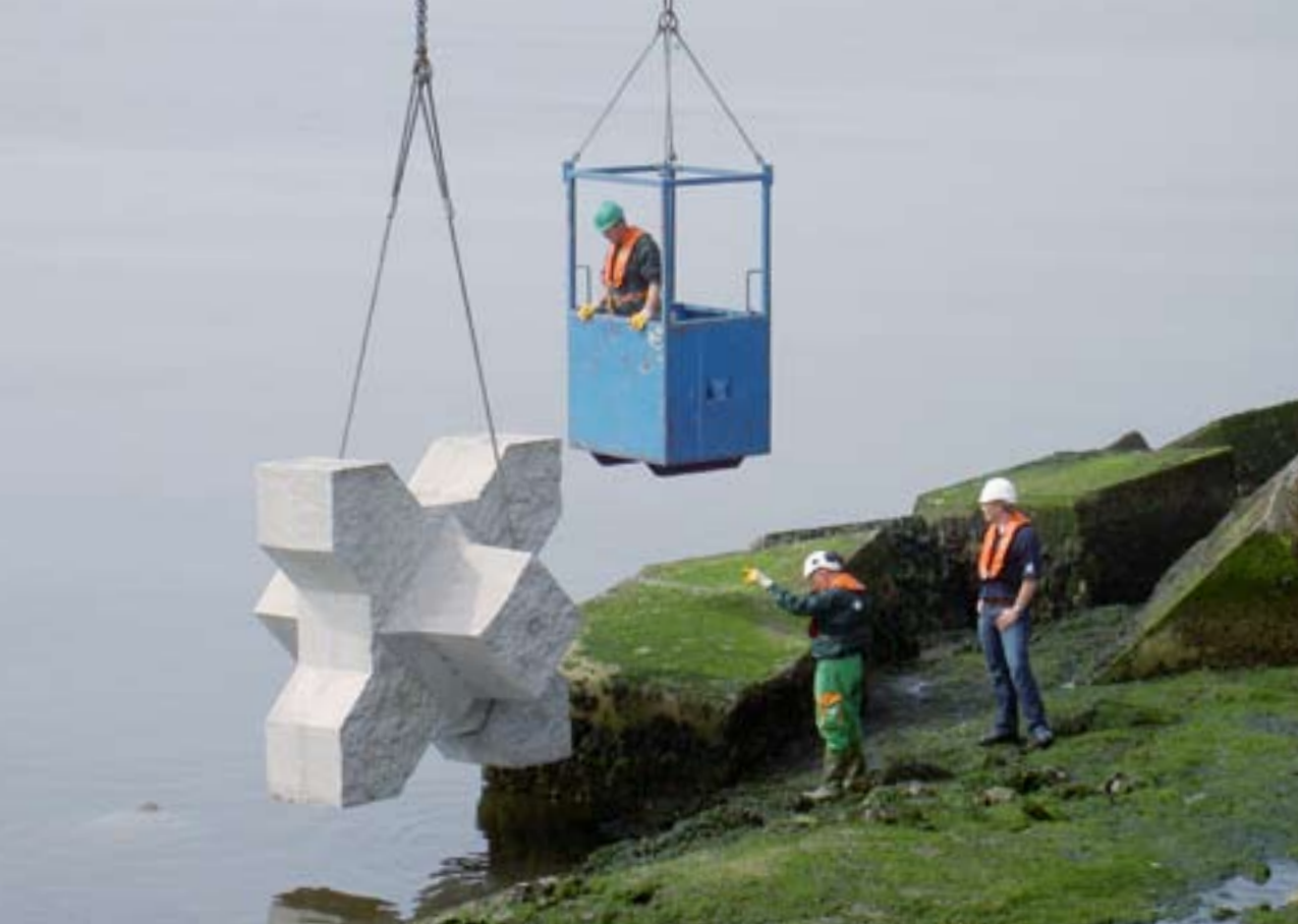
In juni 2008 zijn de eerste eco-Xblocs geplaatst bij de havenpiers van IJmuiden.
