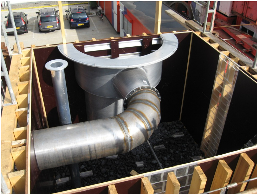
Figuur I.1: Mock-up voorafgaand aan storten van beton.
