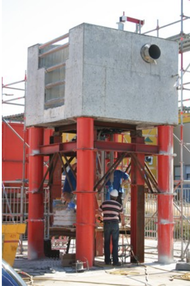
Figuur I.2: Mock-up na het storten en ontkisten, tijdens kernboren.
