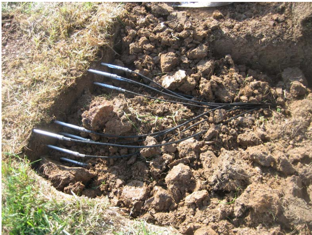
Figuur 5 De sensoren worden zorgvuldig in de voorgeboorde gaten gestoken, waarbij telkens de oorspronkelijke laag aarde wordt teruggestort.
