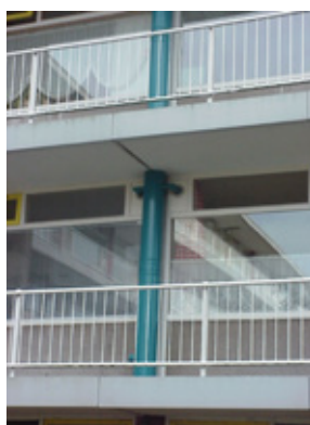
. Aansluiting gesloten toestel op collectieve rookgasafvoer buiten (CRB). Foto's: Vestia Den Haag Zuid-Oost
