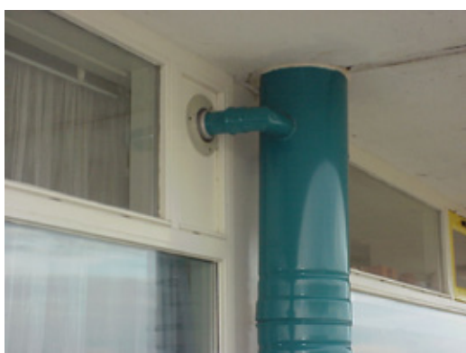
. Aansluiting gesloten toestel op collectieve rookgasafvoer buiten (CRB). Foto's: Vestia Den Haag Zuid-Oost
