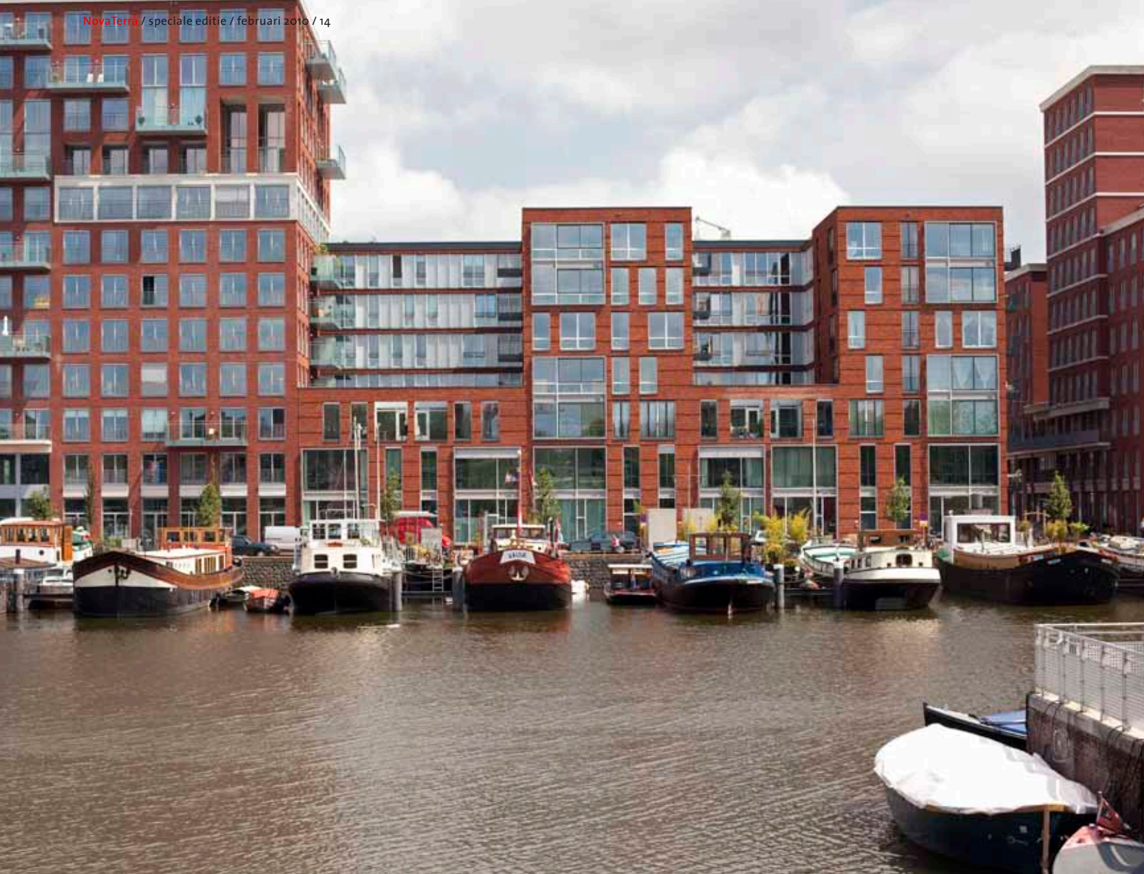
Het Amsterdamse Westerdokseiland heeft een dichtheid van 150 woningen per hectare. (Foto: Thomas Schlijper)
