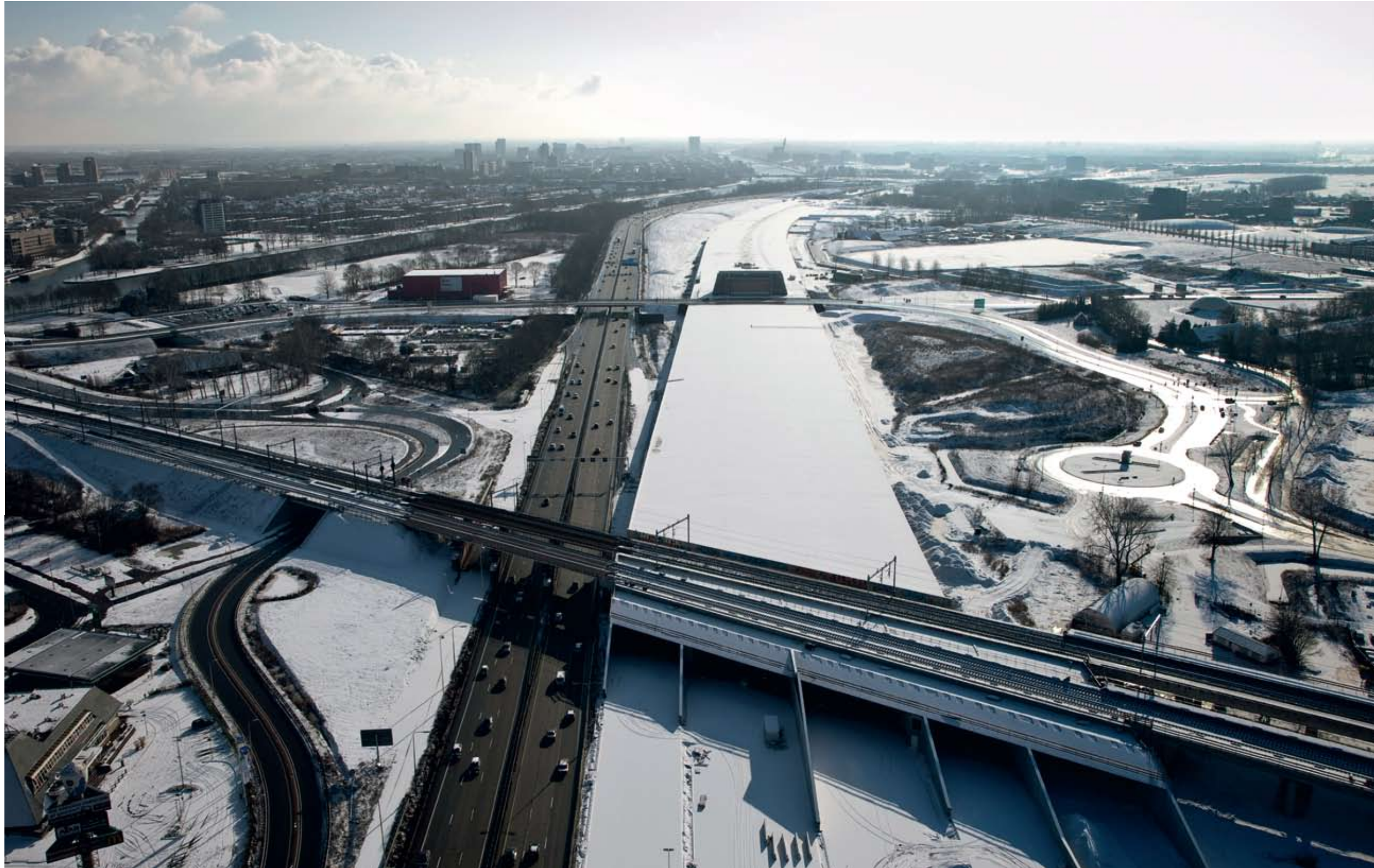
Links: De landtunnel bij Leidsche Rijn. Op het talud wordt een park aangelegd. Onder: Nieuwe flyover bij Eindhoven
