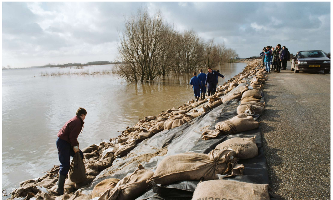
Foto: Noodreparatie met zandzakken bij Ochten tijdens het hoogwater van 1995. Bron: Rijkswaterstaat
