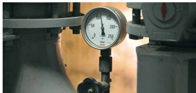
Lage druk meter in gasstation (Foto: SodM)
