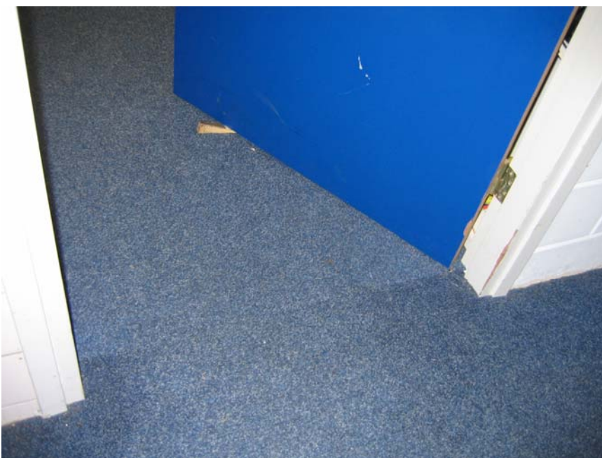
Vastgezette, zelfsluitende brand- en rookwerende deur
