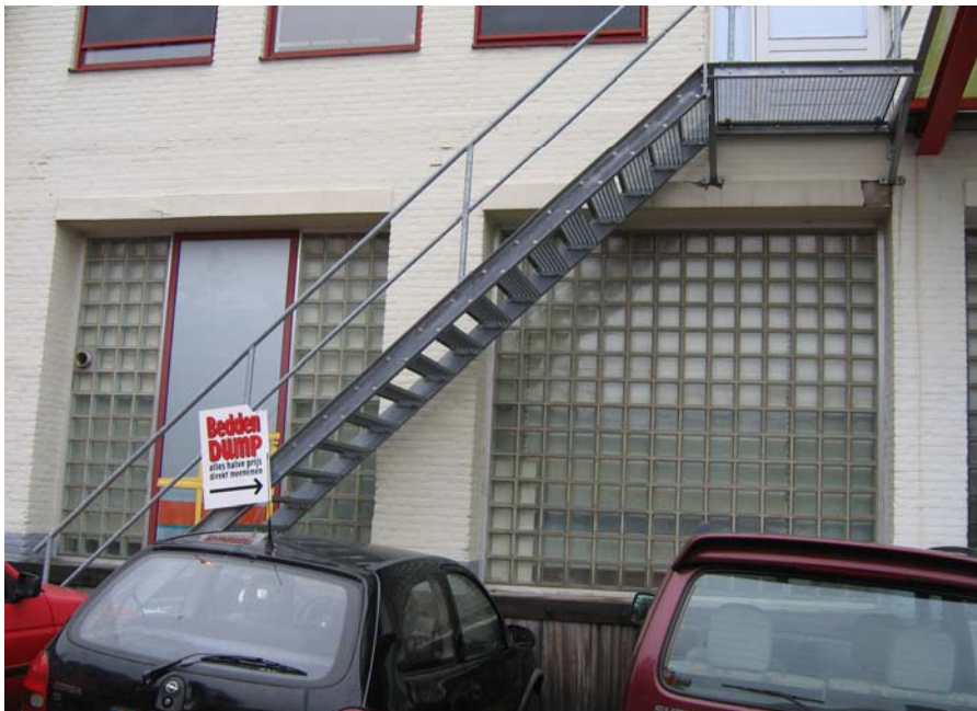
Trapafscheiding met te grote openingen
