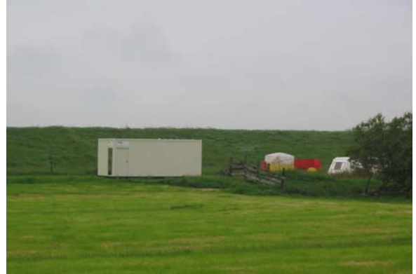
Wc units van de gemeente in Schoorl. Niet vergund/strijdig.
