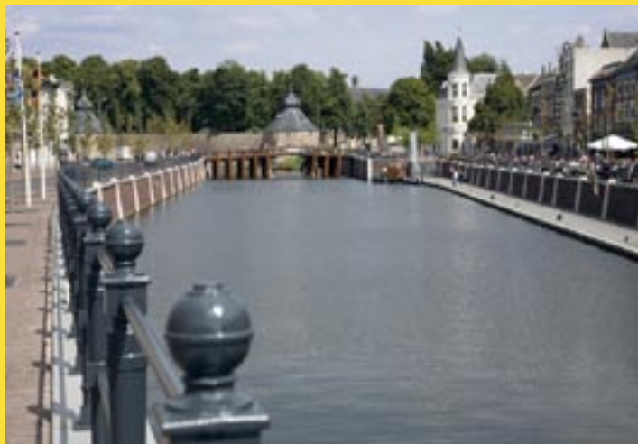
De aanleg van de Nieuwe Mark in Breda. Met dit project wordt er zowel een haven aangelegd, als een mogelijkheid tot waterberging geschapen. In de 60'er jaren van de 20e eeuw werd een soortgelijke haven gedempt. FOTO: HENRI CORMONT /INZICHT-FOTO
