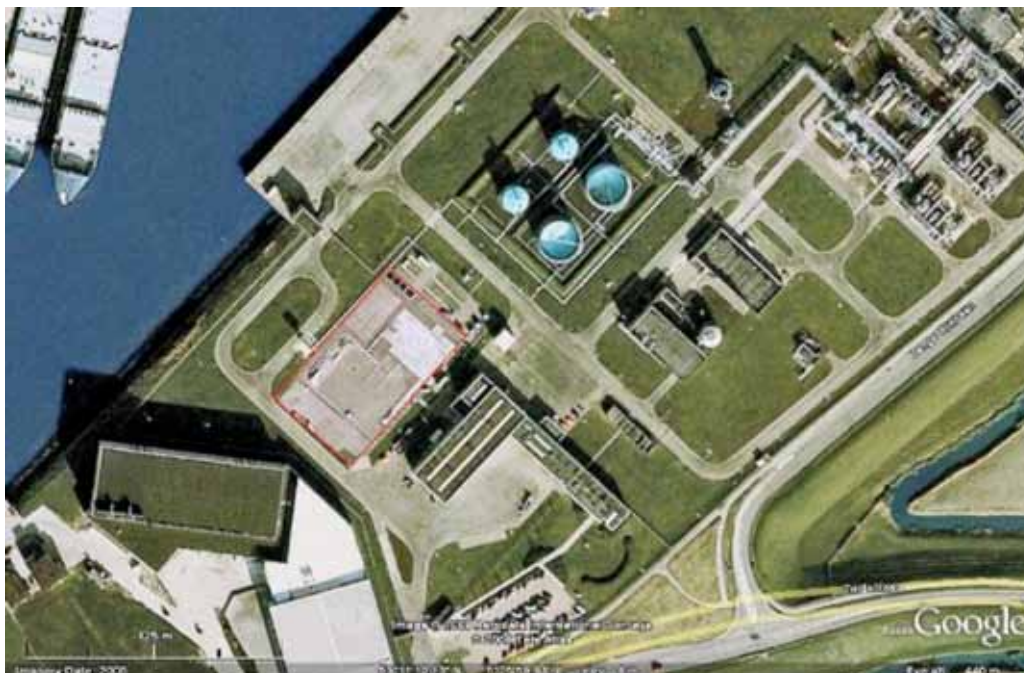
Figuur 6.1 Voorbeeld van een winningslocatie (rode kader) geprojecteerd op de gasbehandelings-installatie van Vermilion.
