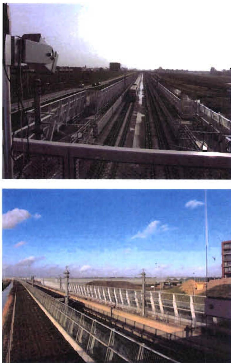
Figuur 3: De tunnelbak in Lansingerland gezien vanaf het viaduct Offenbachlaan tussen het Bachplein en de Witteveenstraat, kijkend richting Rotterdam (boven) en kijkend richting Amsterdam (onder).
