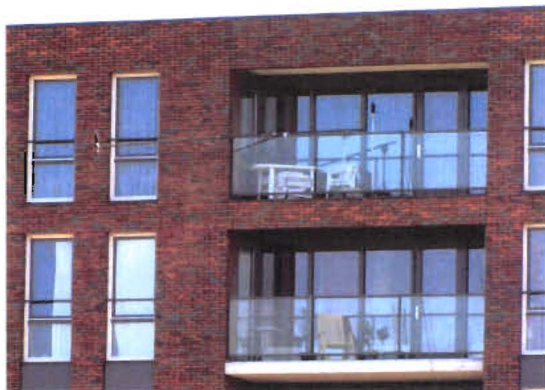
Figuur 2: Overzicht van de meetlocatie Wirtveenstraat, aan de oostkant van het spoor. Microfoons zijn gepositioneerd op 2 meter vóór de gevel van de woning en op het balkon.
