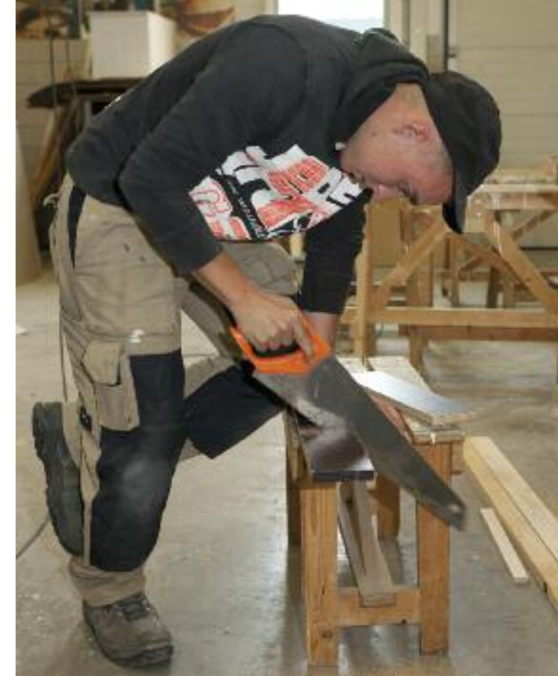
Aan het werk bij de bouwopleiding in Rosmalen
