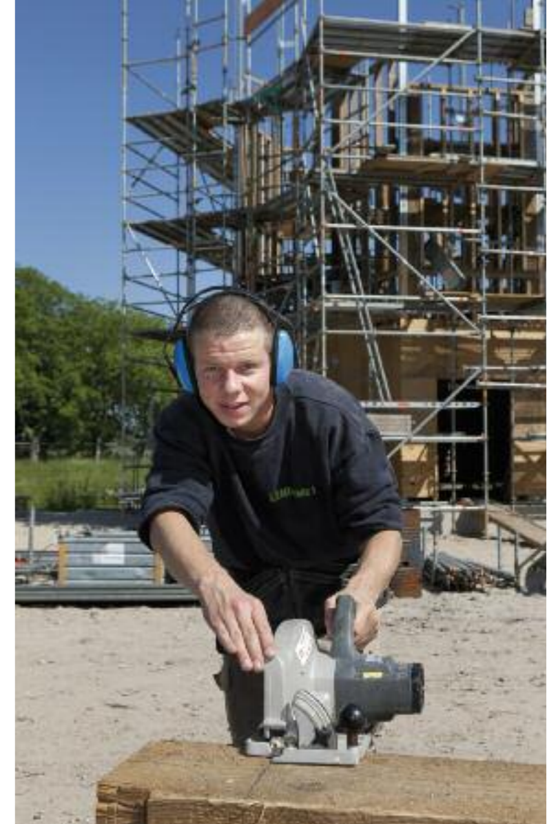
Luuk, met achter hem de toren-in-aanbouw
