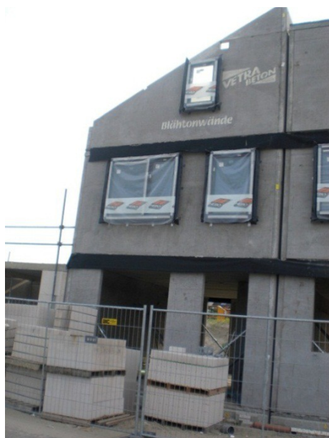
De woning van geïnterviewde bewoner, in aanbouw
