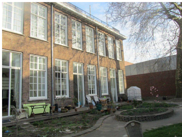
De voormalige Hooimanschool met gezamenlijke binnenterrein.
