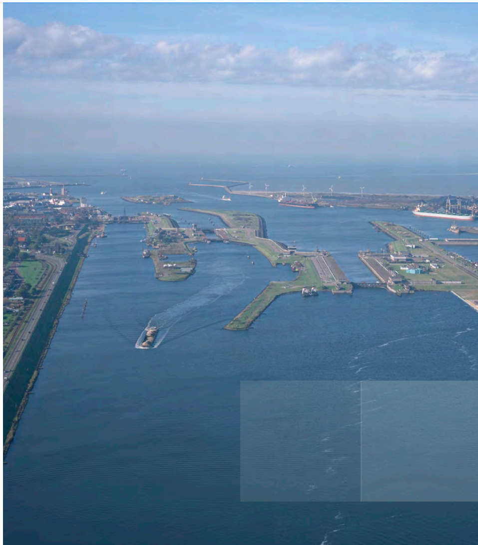
Figuur 29: De sluizen bij IJmuiden
