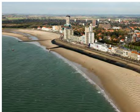
Figuur 5: De boulevard in Vlissingen
