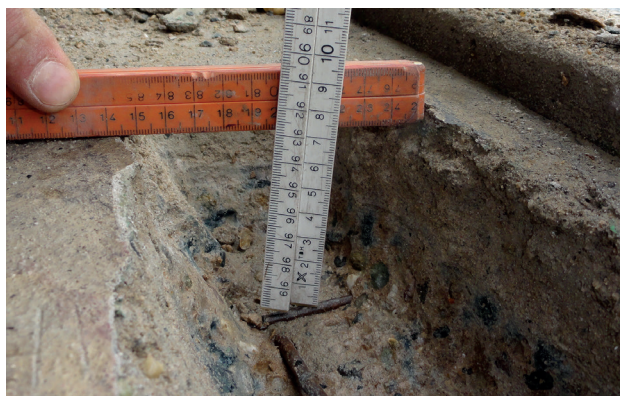
Figuur 3-3 Verificatie wapening vanaf bovenzijde galerijvloer.
