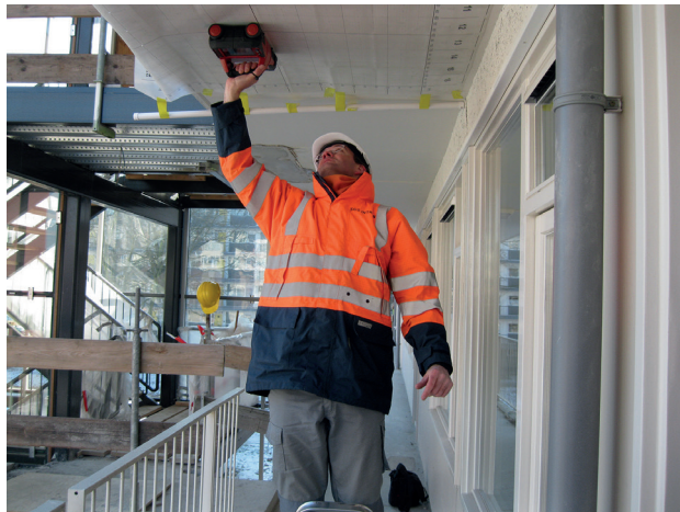
Figuur 3-2 Radarmeting aan onderzijde galerijvloer.
