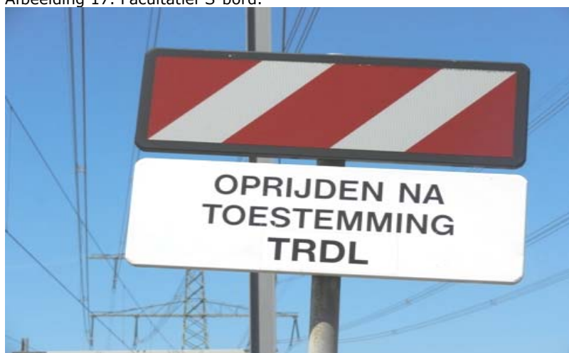
Te zien is een facultatief S-bord met opdracht aan het begin van spoor 891.
