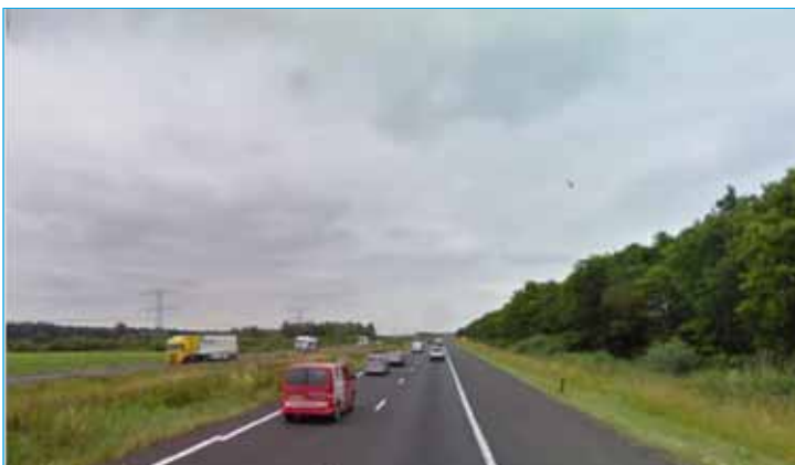
Foto 2: als gevolg van de beperkte capaciteit van de uitvoegstrook, maakt veel verkeer gebruik van de vluchtstrook om voor te sorteren voor de richting Lelystad. Voorbij de uitvoegstrook (op de afrit) is voldoende capaciteit aanwezig om het verkeer verder af te wikkelen.
