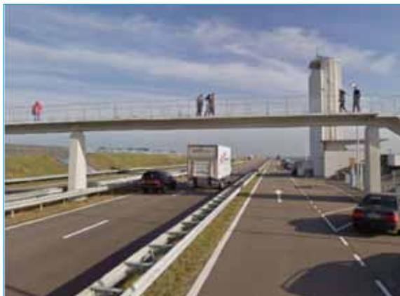
Foto 2: Voetgangersbrug over de A7. Mogelijkheid om matrixborden aan te brengen en de maximumsnelheid op de rijstrook 1 en rijstrook 2 verschillend te maken (bijvoorbeeld R1: 100 km/u en R2: 70 km/u of 90 km/u).
