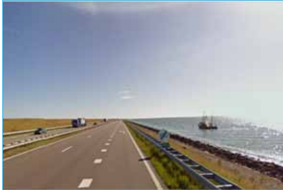
Foto 1: smalle invoegstrook t.p.v. het monument op de Afsluitdijk (HRR). Brede voertuigen zoals toeristenbussen en vrachtauto's rijden bij het gebruik van de invoegstrook al met de linkerbanden op de hoofdrijbaan.
