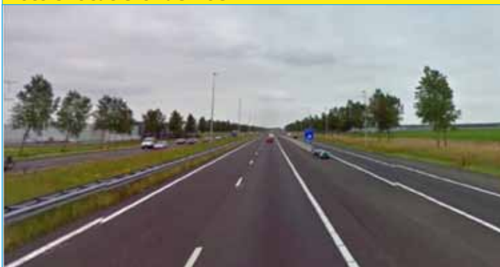
Foto 1: bottleneck voor uitvoegende verkeer: de uitvoegstrook afrit 10 Lelystad (HRR). De capaciteit van de uitvoegstrook is onvoldoende om alle uitvoegend verkeer goed af te wikkelen.
