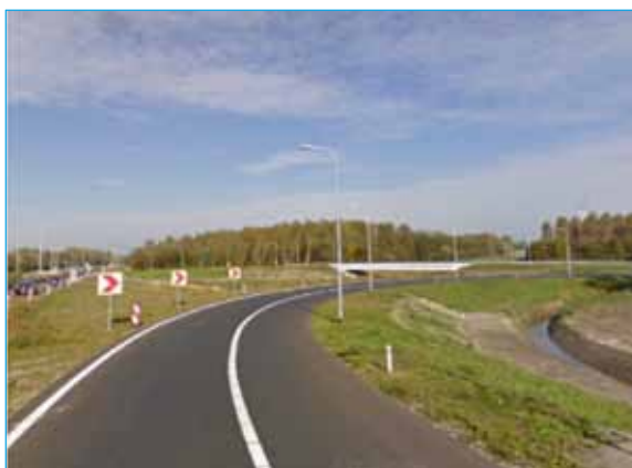
Foto 2: verbindingsboog vanaf de A6 (HRR) richting de N302/ N309.
