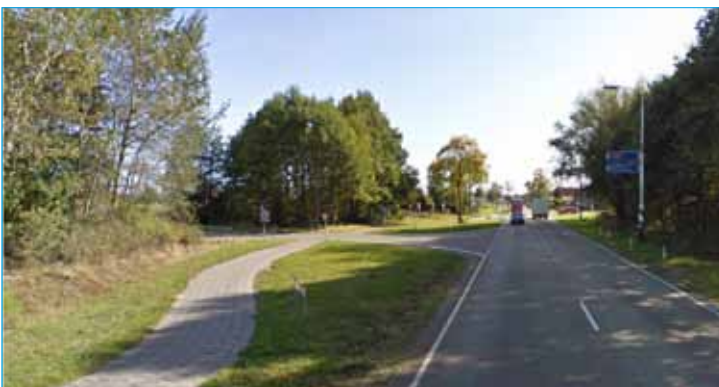
Zicht op kruispunt vanuit westelijke richting (overzichtelijk kruispunt).
