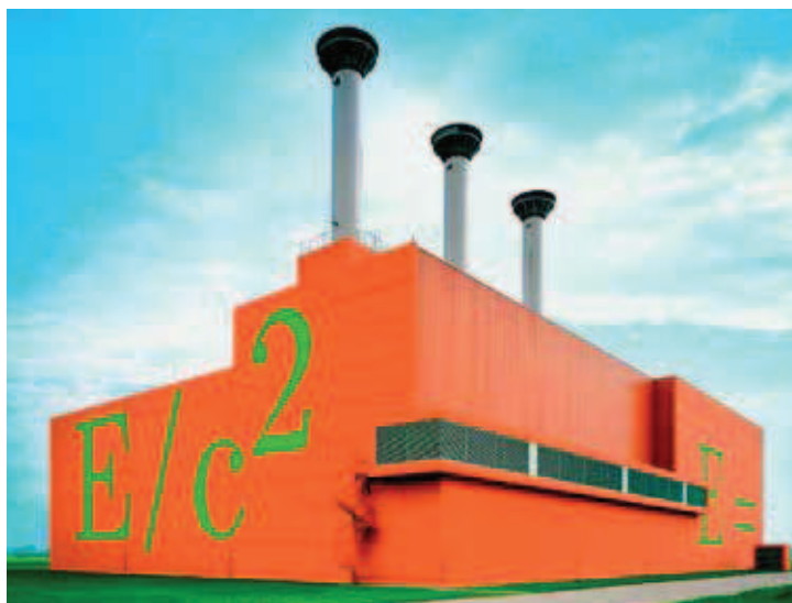
COVRA: Hoogradioactief Afval Behandelings- en Opslag Gebouw
