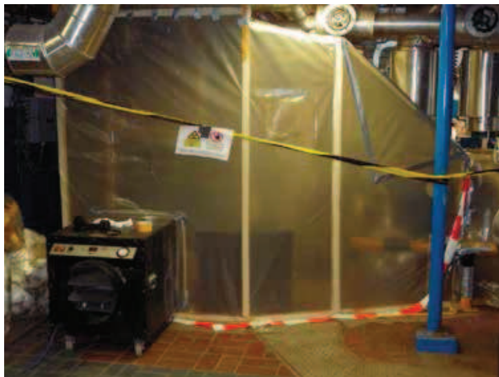
Containment voor sanering slakkenwol met radioactiviteit
