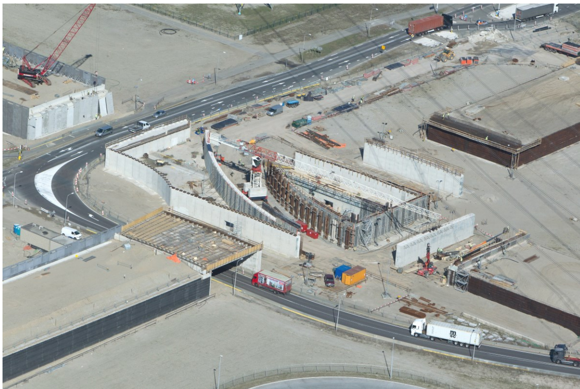
Luchtfoto Coloradoviaduct maart 2014
