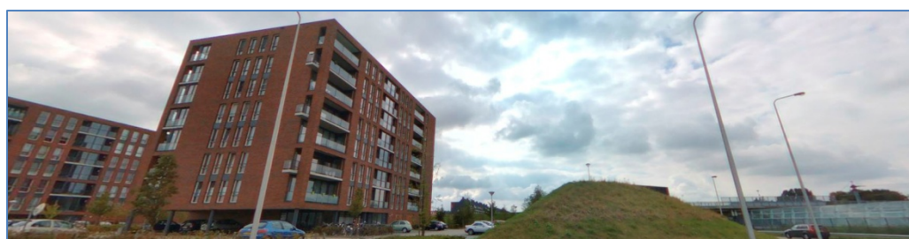
Figuur 46: Woontoren W.G. Witteveenstraat.
