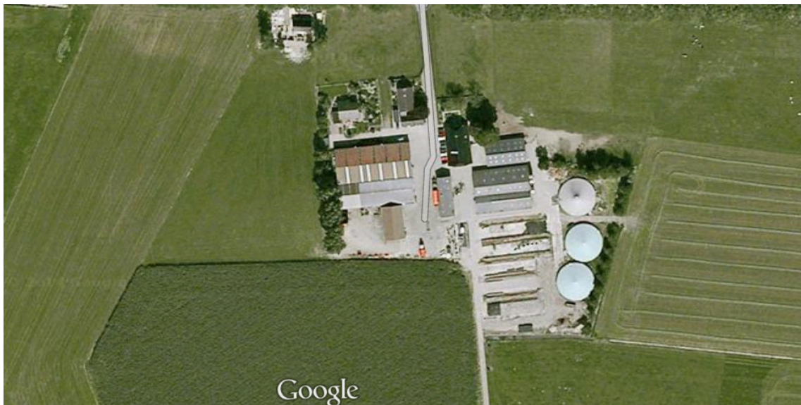
Covergistinginstallatie in het landelijke gebied (Bron: Google Maps)
