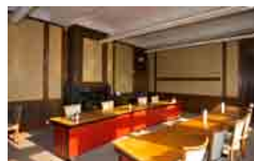
Afb. 173. Ruimte 2.12, met eikenhouten betimmering uit circa 1752, maakt onderdeel uit van de appartementstructuur, 2012
