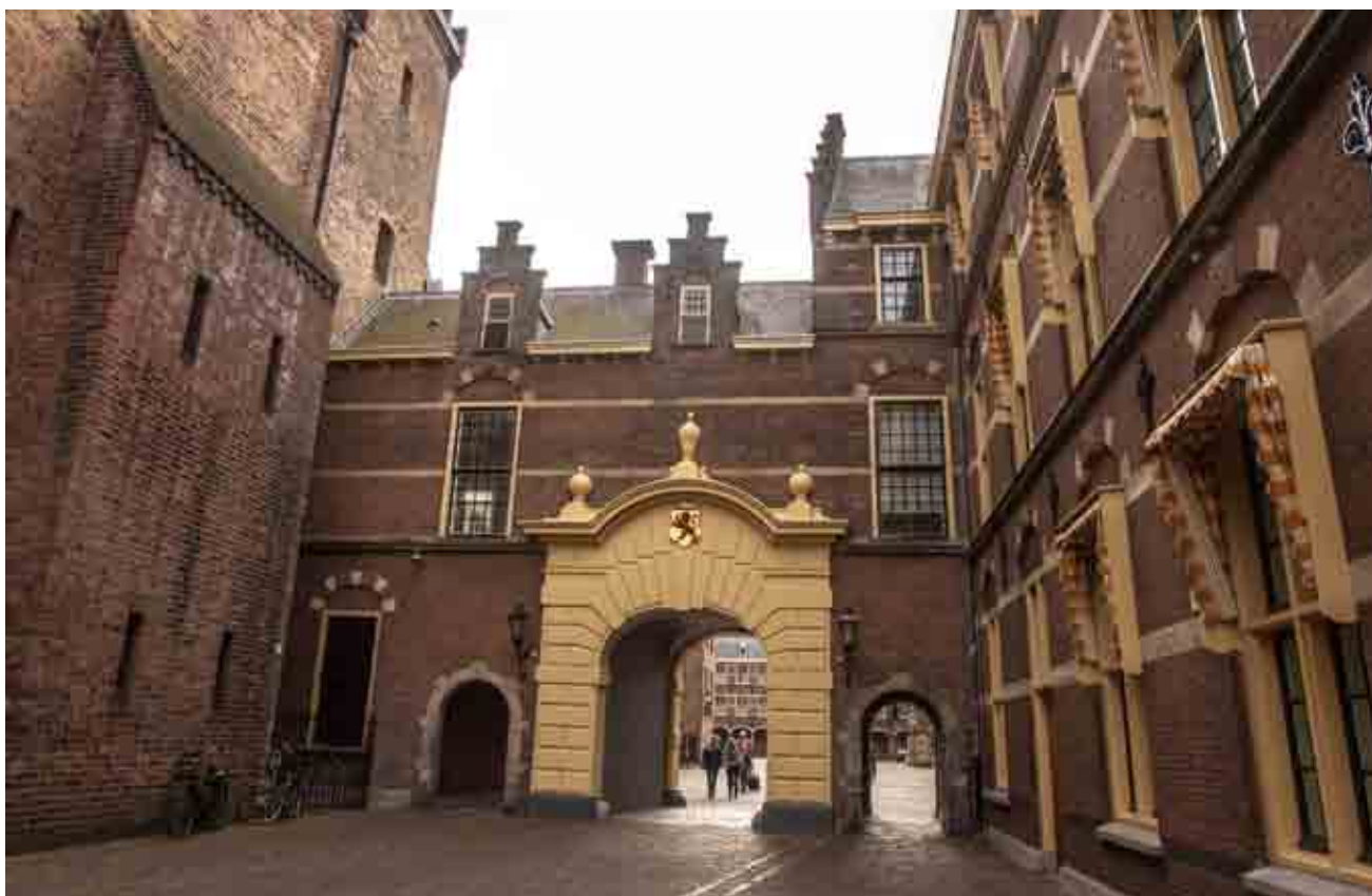
Afb. 284. Historisch straatprofiel tussen Middenpoort en Grenadierspoort tegenwoordig nog enigzins zichtbaar, 2014
