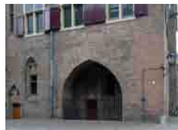
Afb. 273. Toegangen tot kelders, 2013
