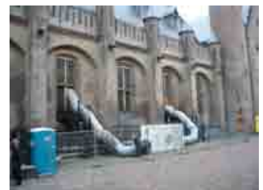
Afb. 254. Tijdelijke koelinstallatie, 2011
