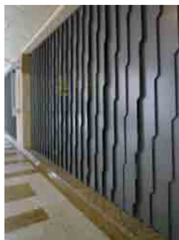
Afb. 443. Gevel commissiekamer met gesloten lamellen, 2012
