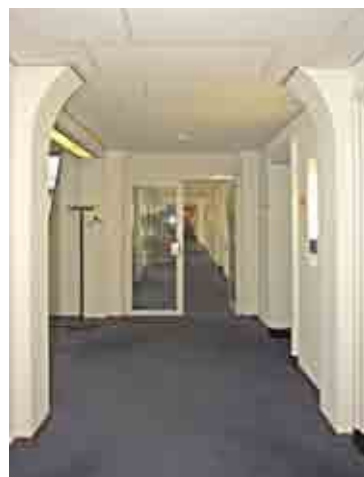
Afb. 388. Verlaagd plafond in een van de gangen, 2014
