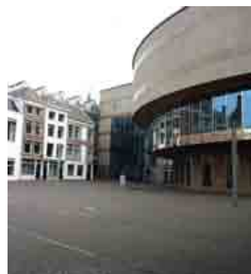
Afb. 113. Hofplaats met de toegang die oorspronkelijk bedoeld was als publieke entree voor de Statenpassage. Nu in gebruik als toegang voor scholieren, 2014
