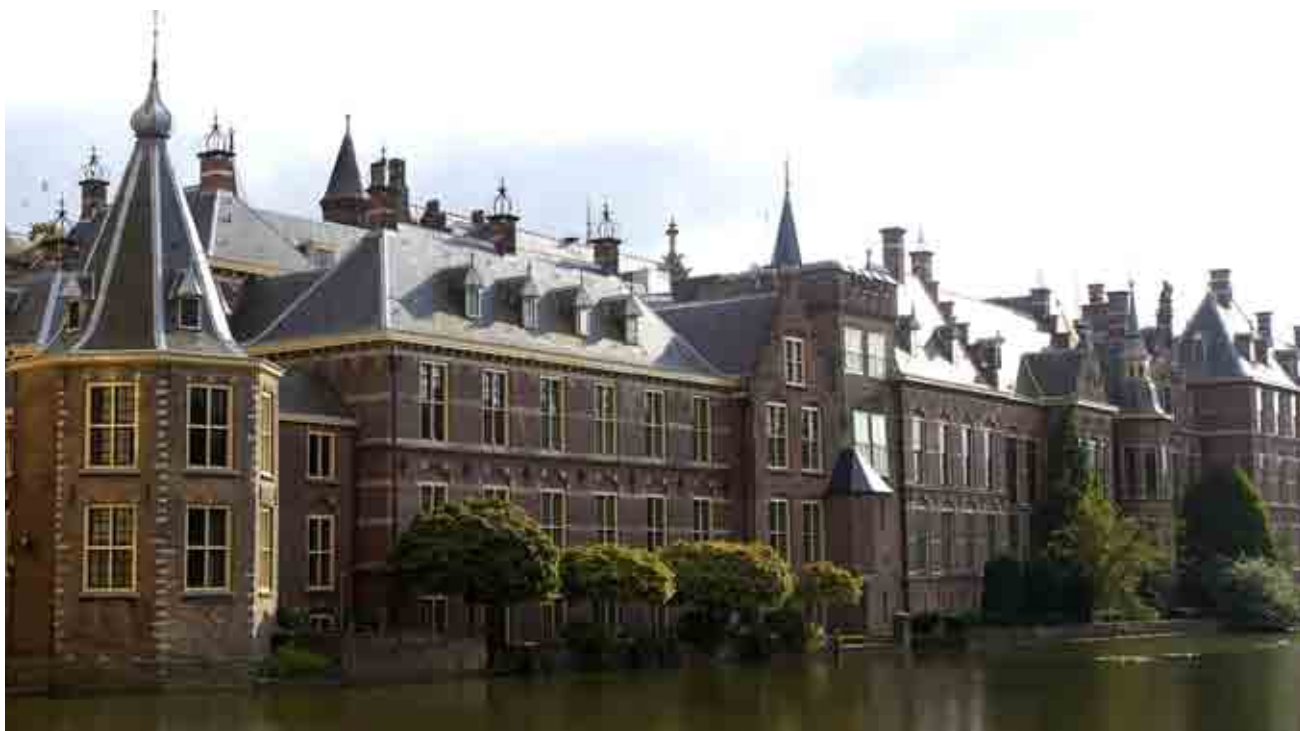
Afb. 125. Gevel Algemene Zaken. Van het Torentje tot de Hofkapel, 2014
