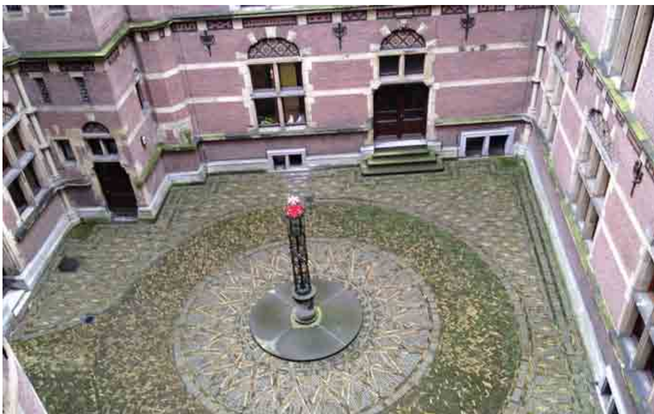
Afb. 227. Binnenplaats voormalig Ministerie van Justitie, 2014
