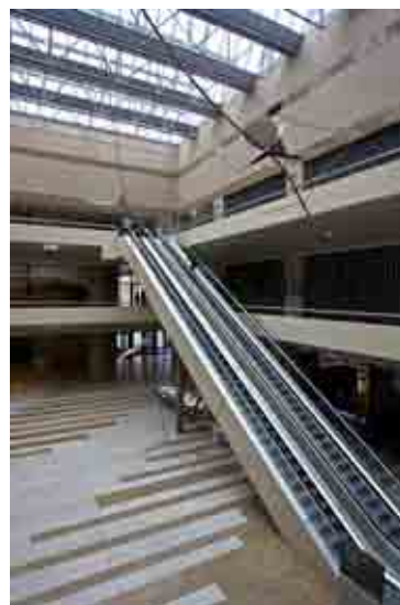
Afb. 236. Roltrappen nieuwbouw Tweede Kamer, 2014
