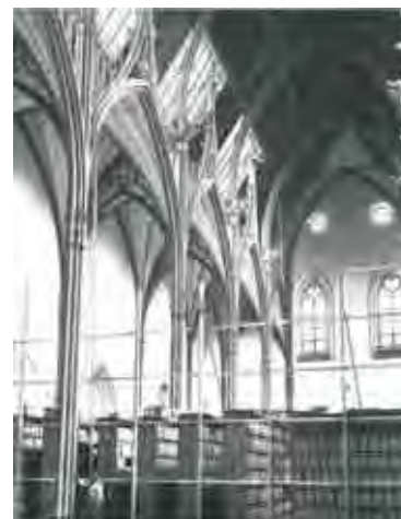
Afb. 73. Gietijzeren kap in de Ridderzaal, 1860
