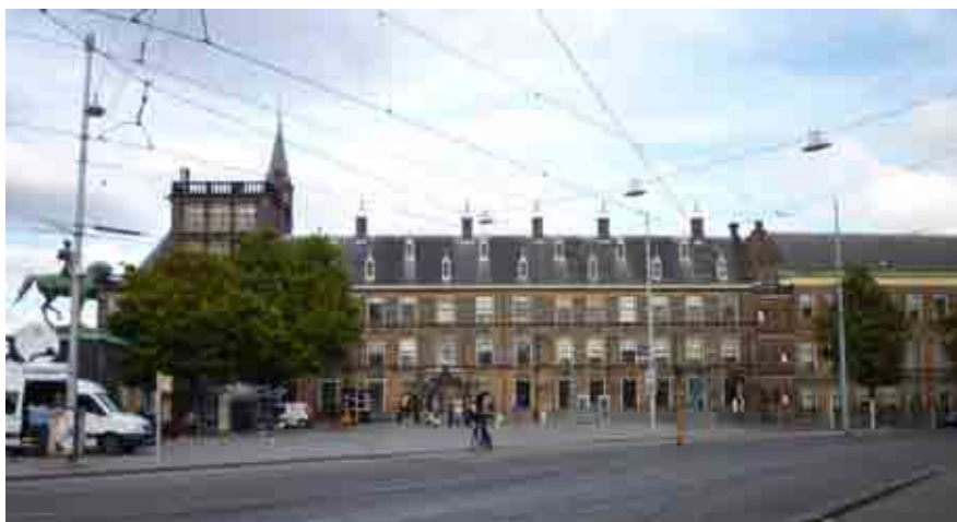
Afb. 302. Binnenhofcomplex aan het Buitenhof, 2012
