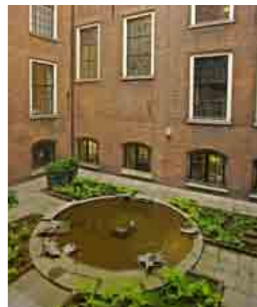
Afb. 468. Patio in bouwblok A van de Tweede Kamer, 2014
