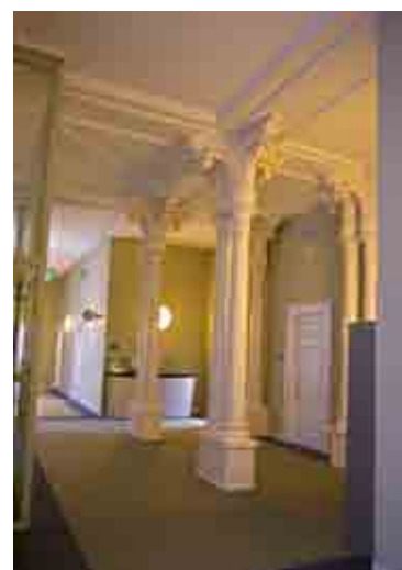
Afb. 225. Gietijzeren zuilen in voormalig Ministerie van Koloniën, 2014
