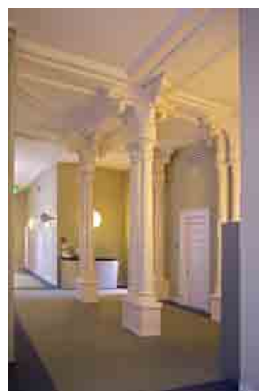
Afb. 106. Hal met gietijzeren kolommen in Ministerie van Koloniën; de vide is dichtgelegd, 2014
