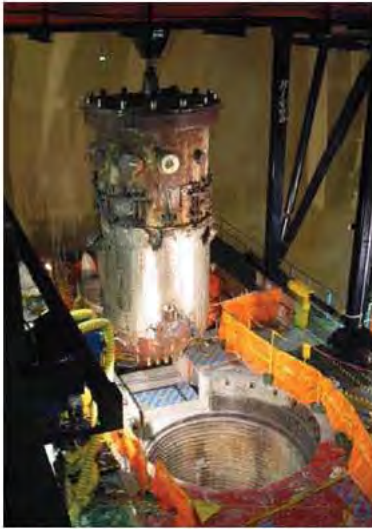
Foto 14. Big Rock Point-Michigan, USA: Verwijdering van het reactorvat in één stuk bij GKN's zustercentrale.
