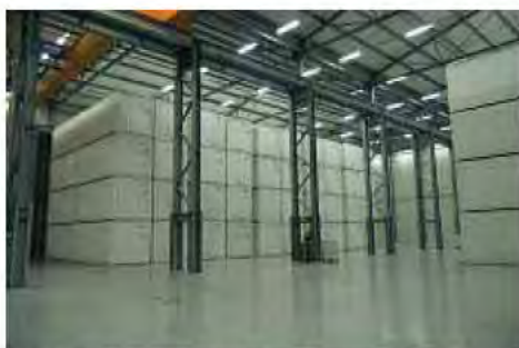
Foto 7. COVRA-NL: Container Opslag Gebouw (COG), containers gevuld met zeer licht radioactief materiaal.
