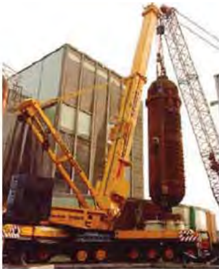
Foto 12. Berkeley-UK: Stoomgenerator wordt uitgehesen.
