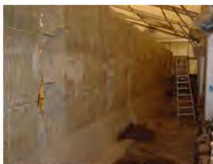
Foto 6. Eurochemie-Mol, België: beton verwijderd uit wand voor nalig bezinkdassin.
