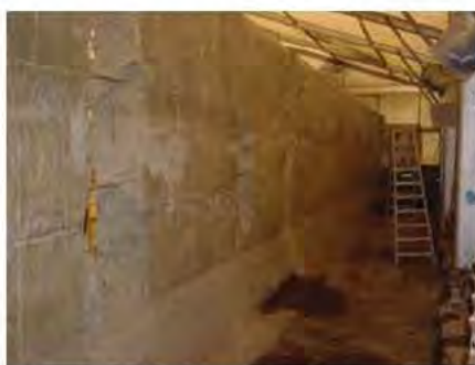
Foto 6. Eurochemie-Mol, België: beton verwijderd uit wand voor nalig bezink bassin.
