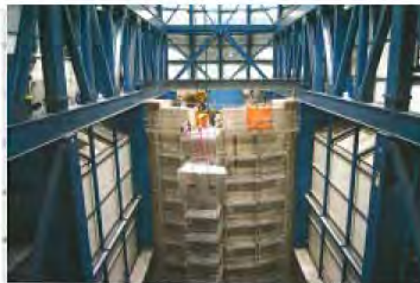
Foto 4. AVR-Jülich, BRD: Uitnemen verzaagde betonblokken uit biologisch schild.
