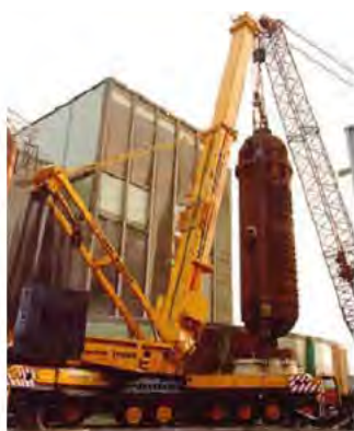
Foto 12. Berkeley-UK: Stoomgenerator wordt uitgehesen.
