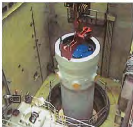
Foto 10. Rheinsberg-BRD: uithijzen reactor in één stuk.
