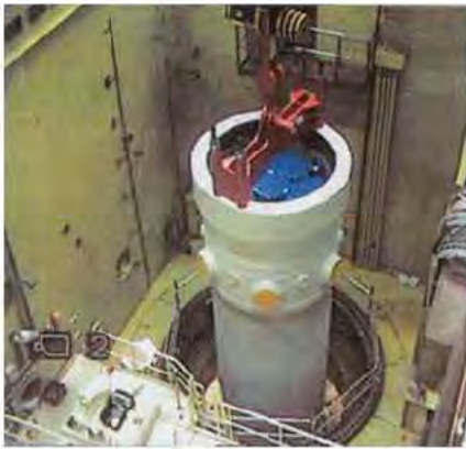
Foto 10. Rheinsberg-BRD: uithijzen reactor in één stuk.
