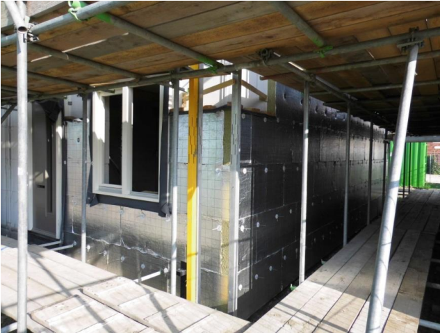
Figuur 4: Een goede thermische schil als basis voor EPC < 0,4
