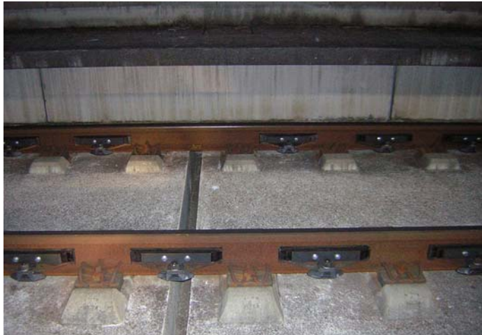
Figuur 2: Raildempers in het proefvak op de HSL
