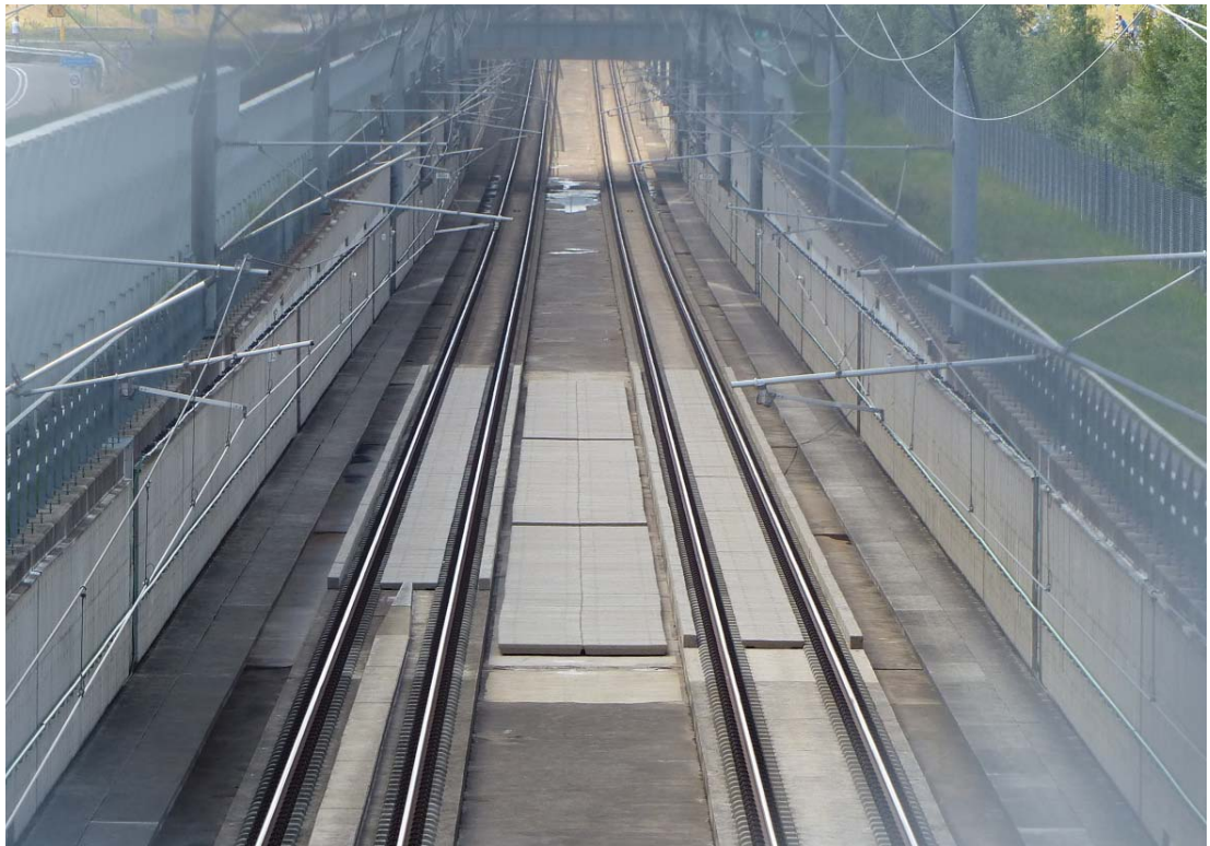
Figuur 4: Proefvak op de HSL met geluidabsorberende platen
