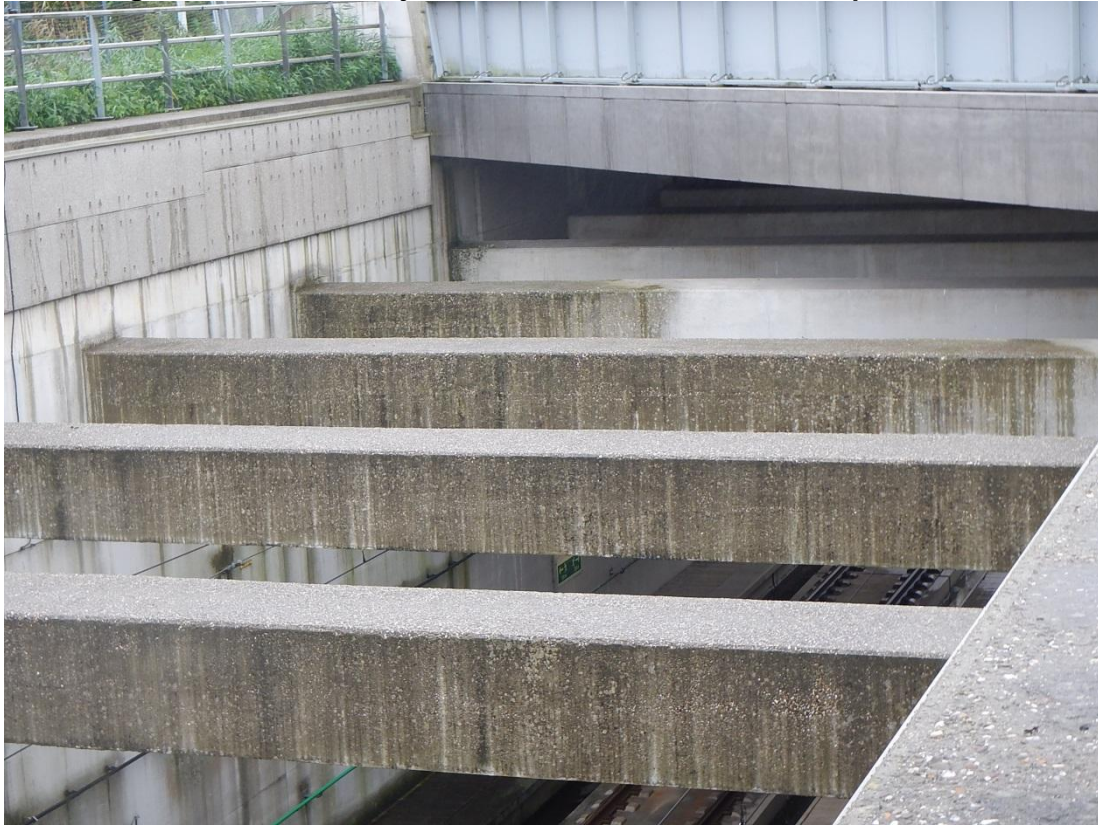
Afbeelding 6.3. Verschil uiterlijk zijanten en onderzijde stempels
