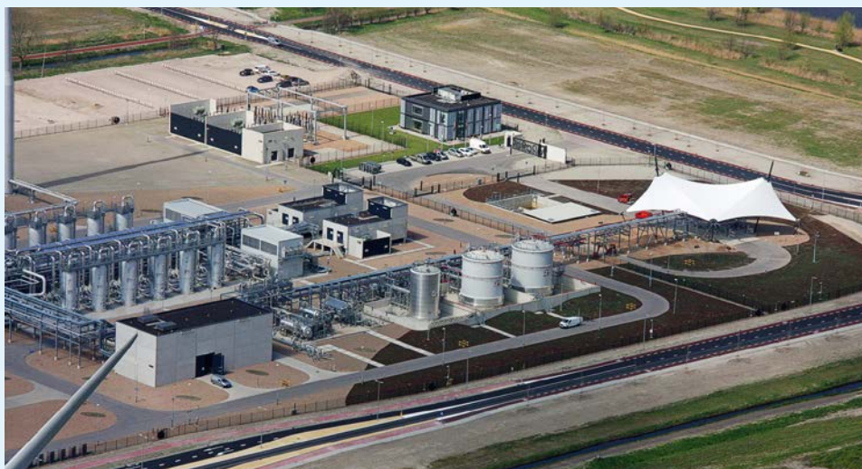
Overzichtsfoto van de gasbehandelingsinstallatie Boekelermeer (foto TAQA)
