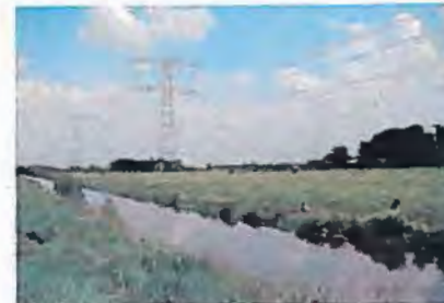
Voorbeeld huidige situatie: aan 2 circuitsverbinding in een vakkermast
