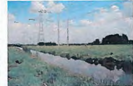
Voorbeeld nieuwe situatie: bundelen (bestaande vakkermast naast een nieuwe 2 circuitsverbinding in bipolarmast)
