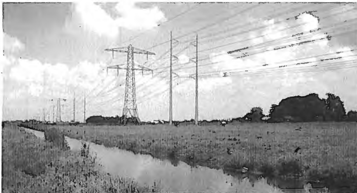
Figuur 4 Een vakwerkmast (links) en bipolemast (rechts)
