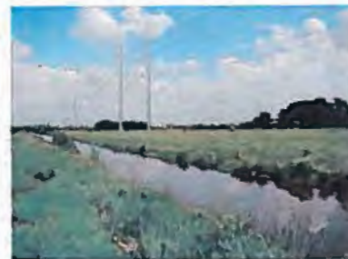
Voorbeeld nieuwe situatie: combineren (bestaande en nieuwe verbinding samen in één nieuwe 4 circuitsverbinding uitgevoerd in een bipolarmast)
