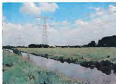
Voorbeeld huidige situatie: een 2 circuitsverbinding in een vakkermast
