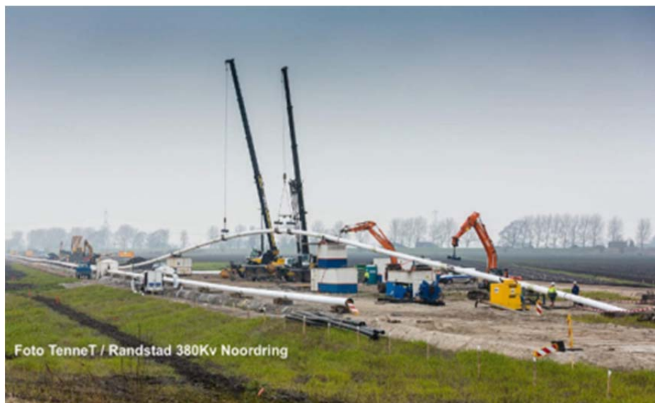
Figuur 16: Boring Randstad 380 kV
