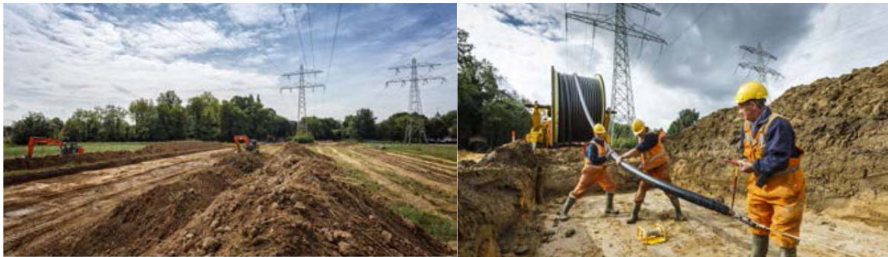
Foto 19: Open ontgraving, sleuven graven en kabels trekken.
