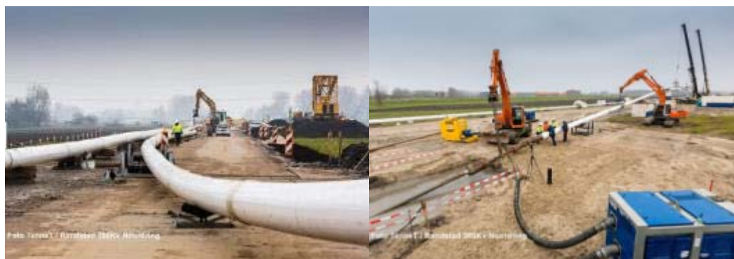
Figuur 17: Boring Randstad 380 kV
