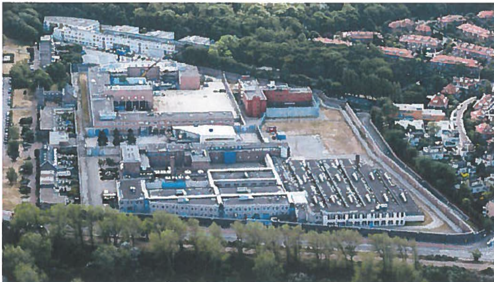
Luchtfoto van de gevangenis in Scheveningen. © ANP.
