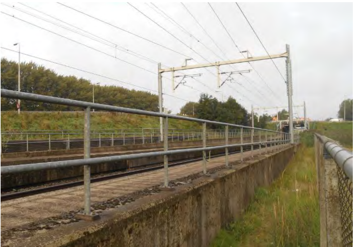
Afbeelding 5.2. Overzicht buitenwanden moot 03 (geringe mosgroei)
