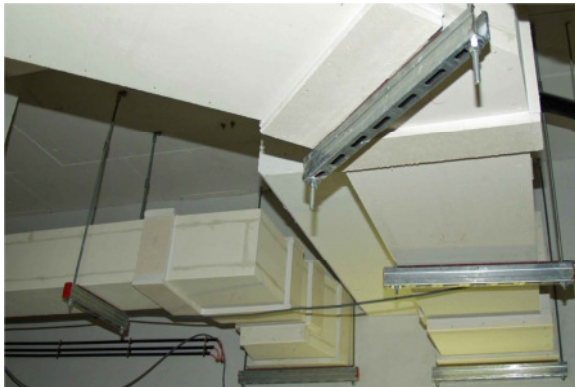
Afbeelding 3.1: ventilatiekanalen met brandwerende bekleding/isolatie ( S_{200} -kwaliteit)
